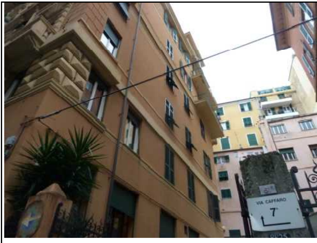
Foto 2 – particolare facciata su distacco carrabile
