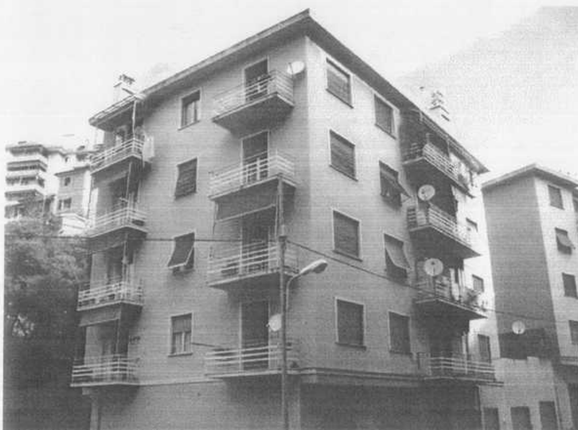
Foto 2: Prospetto sud ed est
