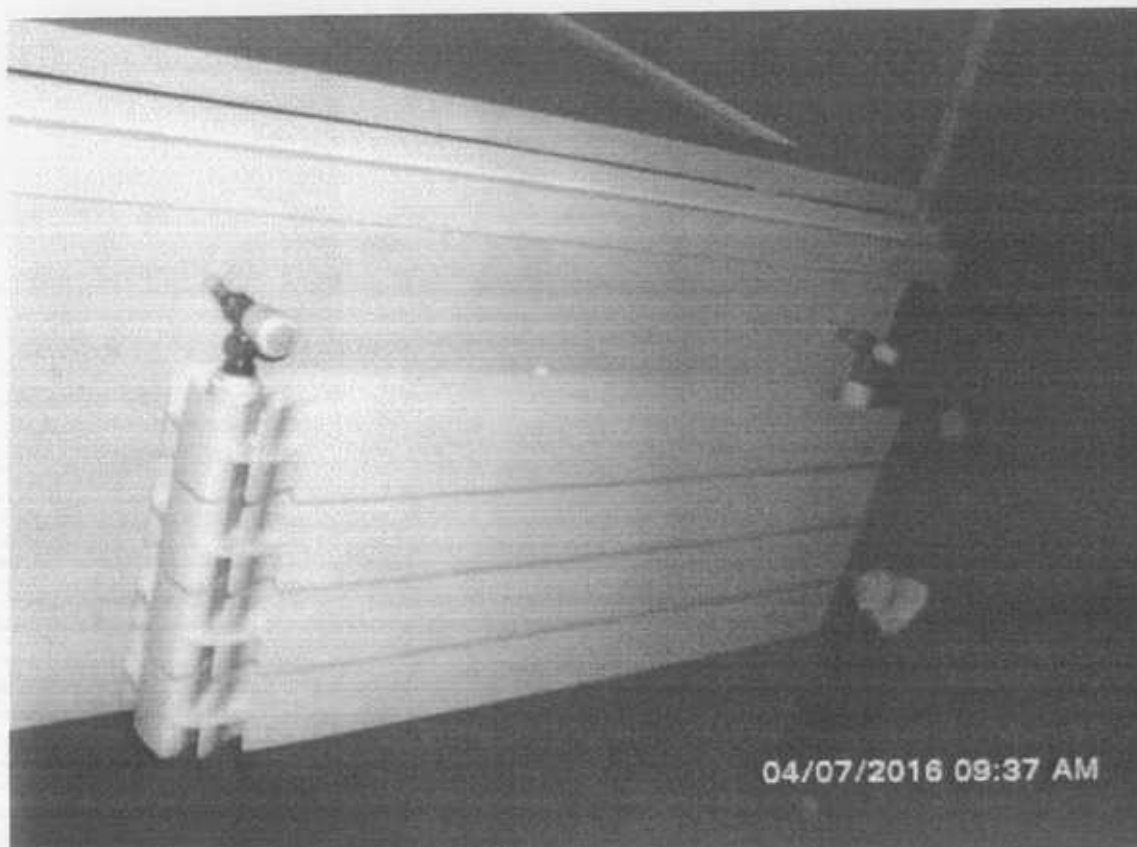
Foto 16: Tipologia di termosifoni installati
