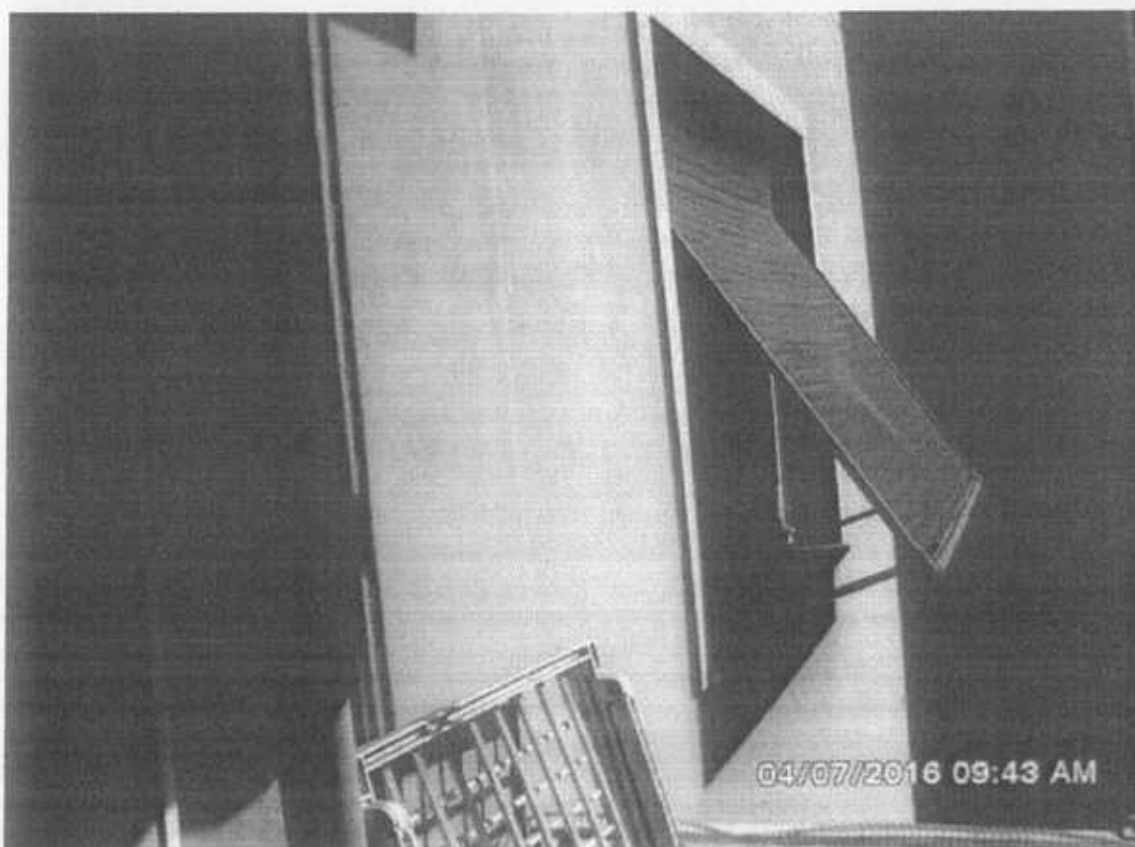
Foto 20: Tipologia di tapparelle installate
