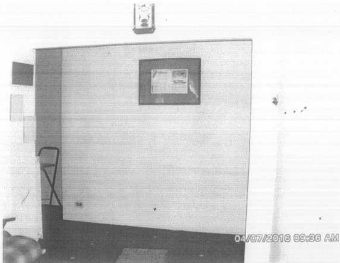
Foto 13: Parete abbattuta tra corridoio e cucina
