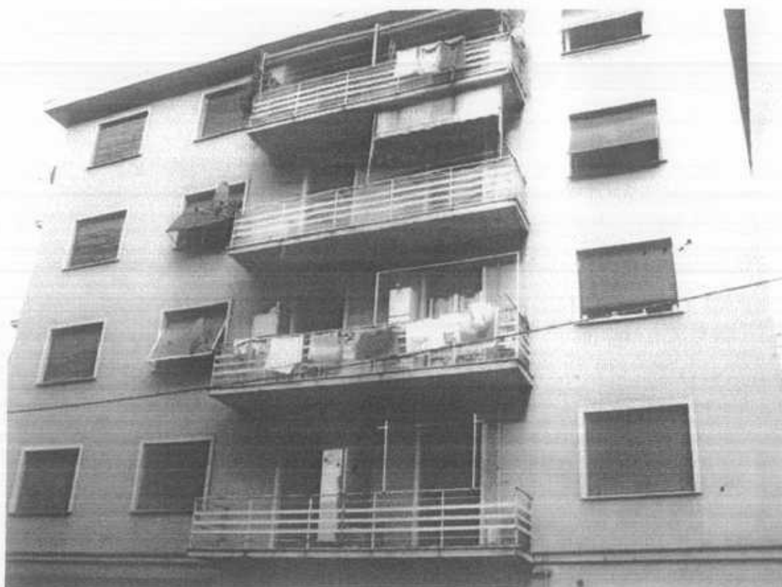
Foto 1: Prospetto su Via Daneo
