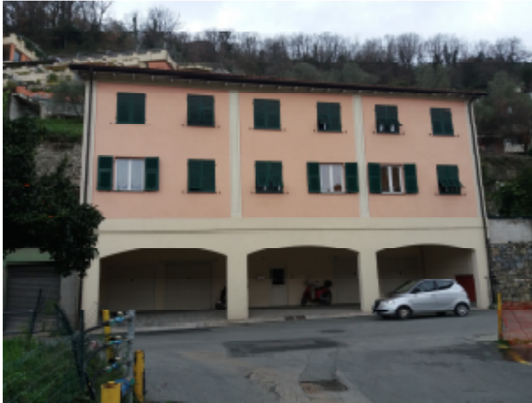
1 – Prospetto est dell'edificio su Via Parma
