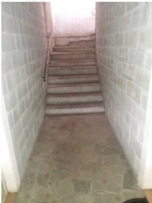
5 – Disimpegno condominiale al P.T.
