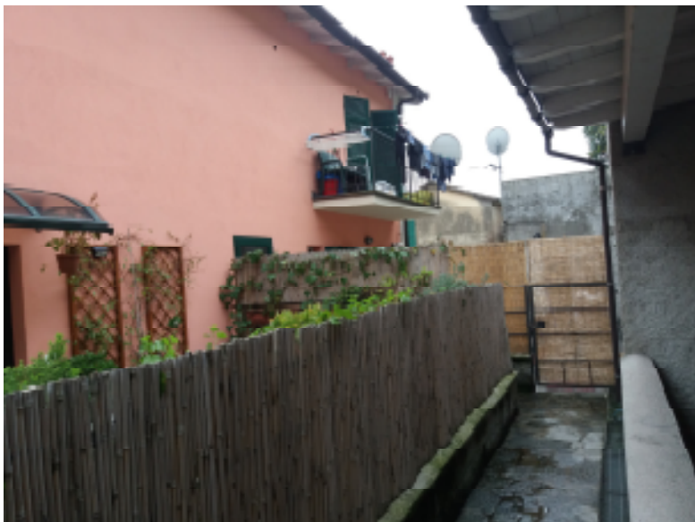
3 – Prospetto ovest dell'edificio e disimpegno esterno condominiale
