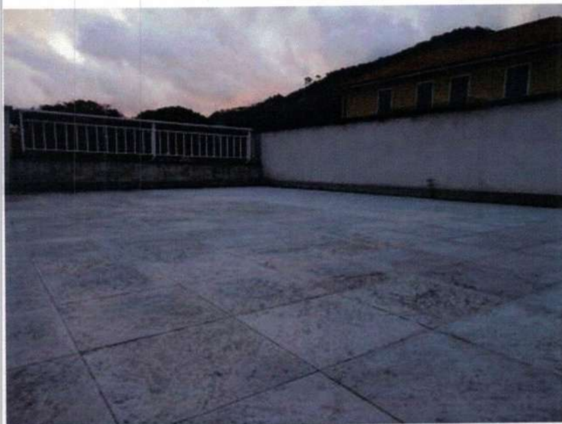
FOTO N° 19 – terrazzo soprastante all'abitazione
