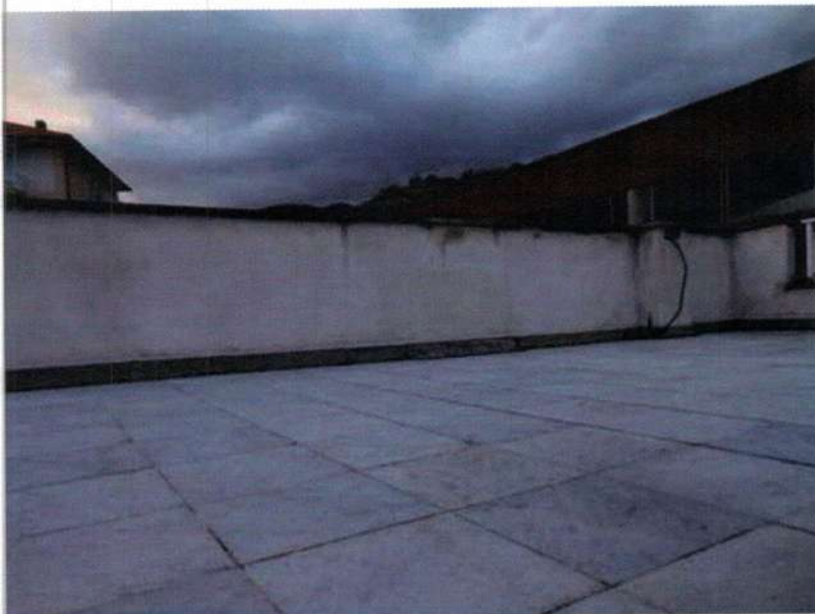
FOTO N° 18 – terrazzo soprastante all'abitazione
