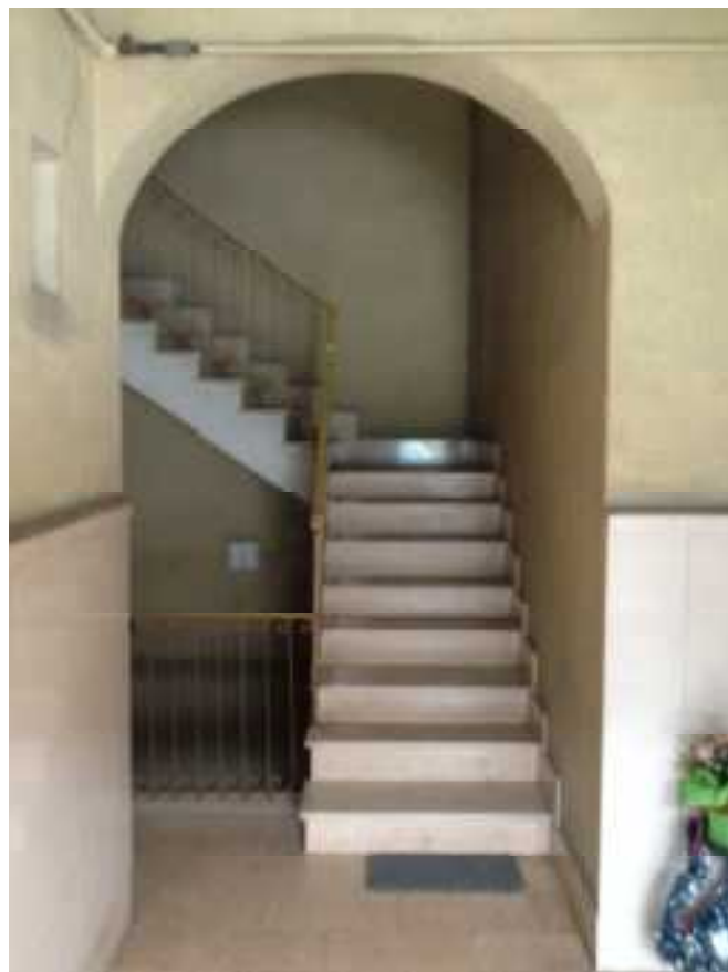
FOTO 4: Vano scale del civ. 5 di Via Colano.
