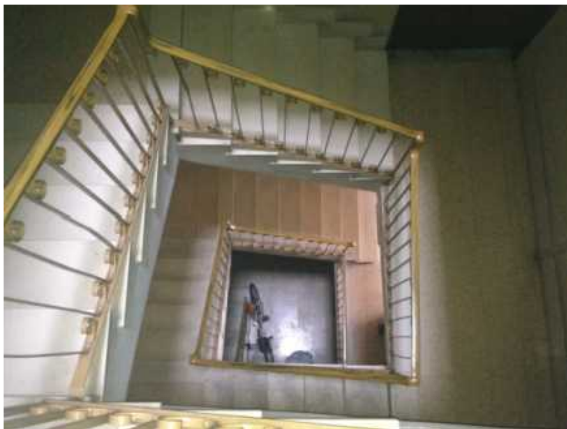
FOTO 5: Vano scale del civ. 5 di Via Colano.
