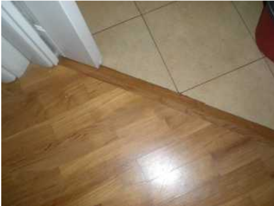
pavimento corridoio/servizio igienico
