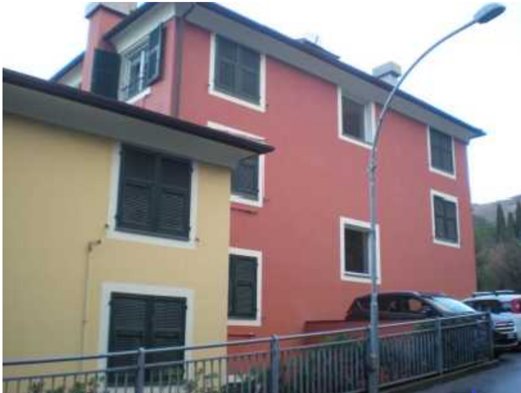
Fronte edificio lato levante su Via Guglielmo Marconi
