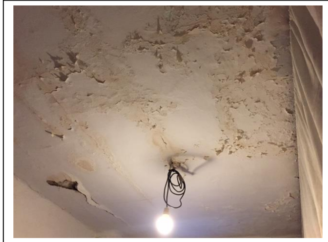
Foto n. 14 : infiltrazioni in cucina
