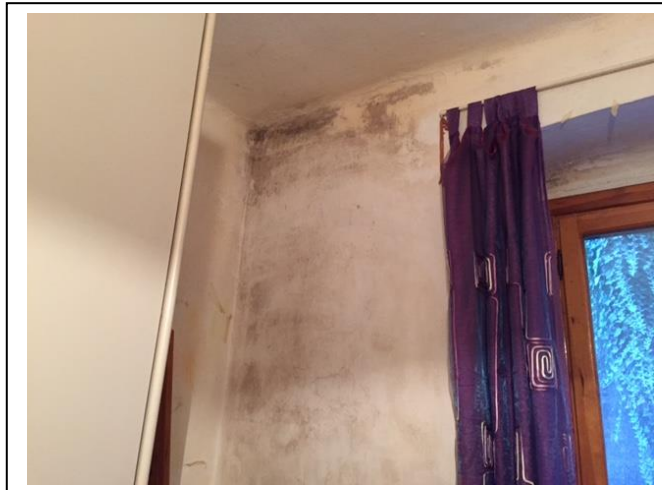
Foto n. 16 : umidità nella parete verso il muraglione
