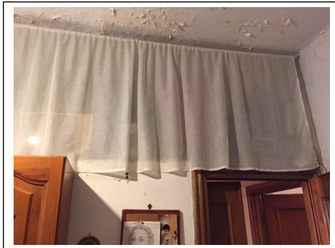
Foto n. 12 : ripostiglio sopra il servizio igienico
