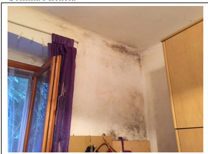
Foto n. 17 : umidità nella parete verso il muraglione
