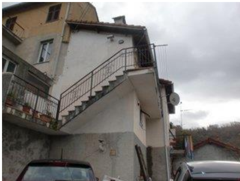
Foto n.2 scala di ingresso
