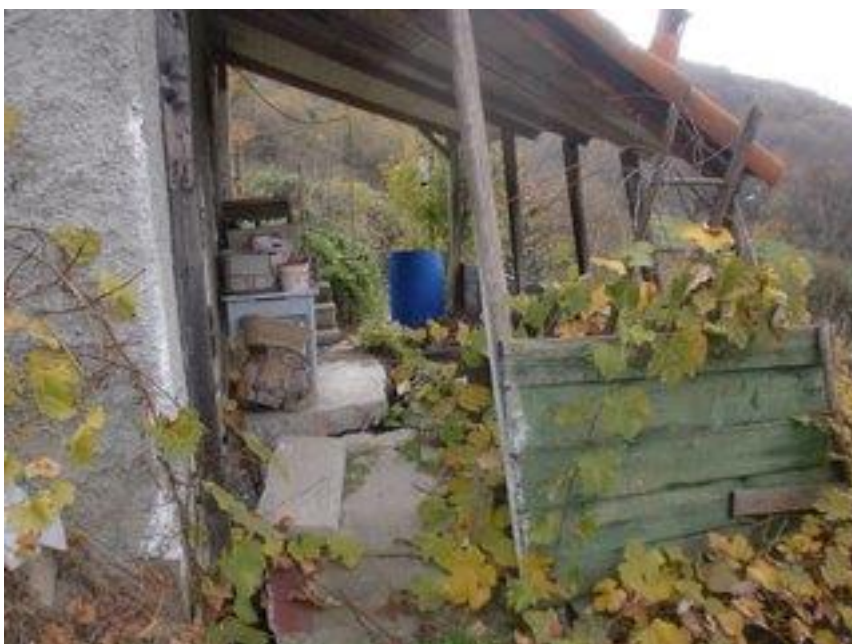
Foto n. 18 fabbricato uso magazzino
