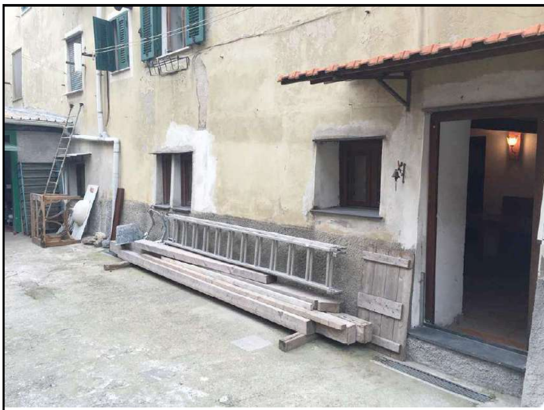
Foto 24 – Cantine Piano Terra (Alloggio abusivo) Via Fegino 5 (Lotto 4°)
