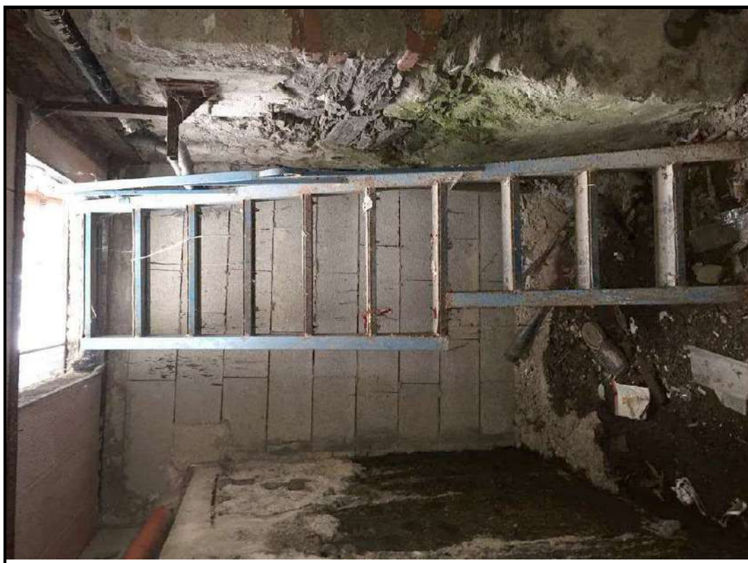
Foto 27 – Cantine Piano Interrato Via Fegino 5 (Lotto 4°)
