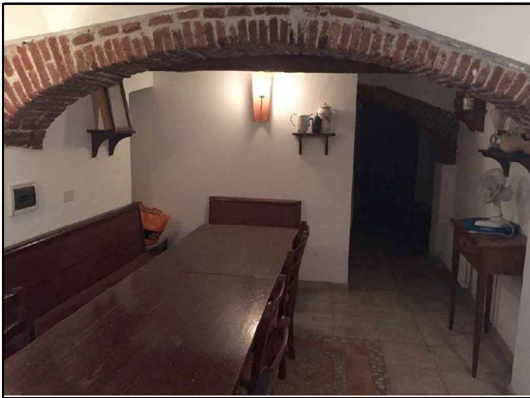
Foto 25 – Cantine Piano Terra (Alloggio abusivo) Via Fegino 5 (Lotto 4°)
