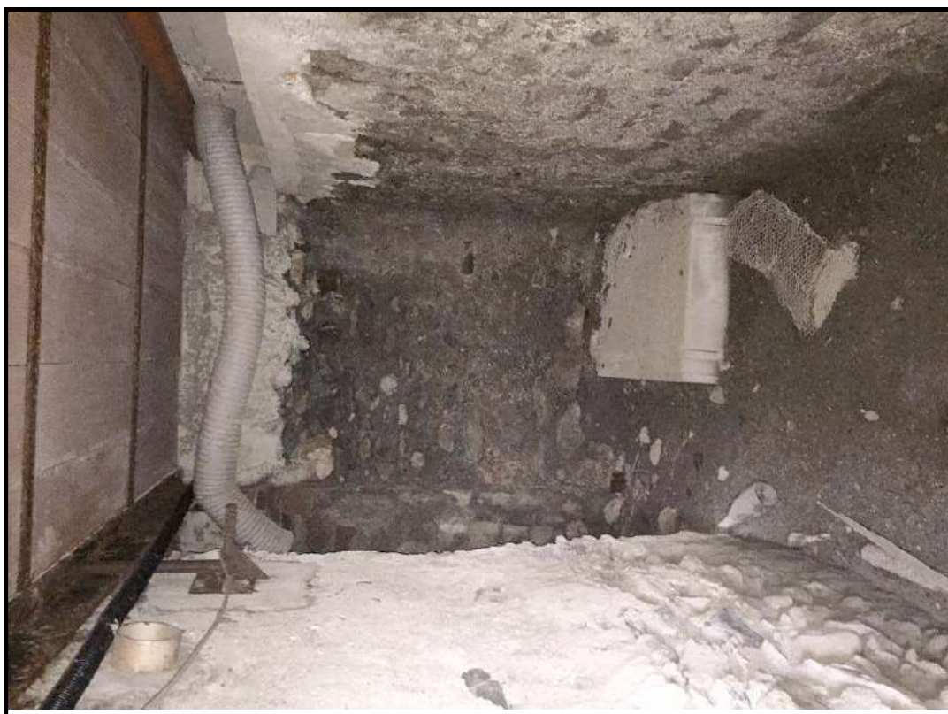
Foto 29 – Cantine Piano Interrato Via Fegino 5 (Lotto 4°)
