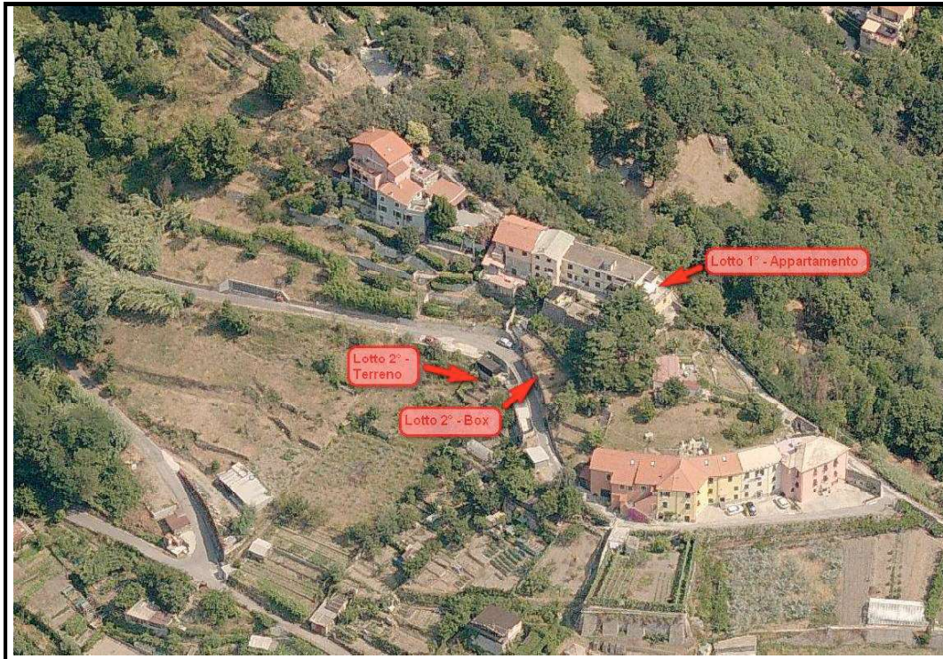
Foto 1- Panoramica Immobili Via di Burlo (Lotti 1° e 2°)
