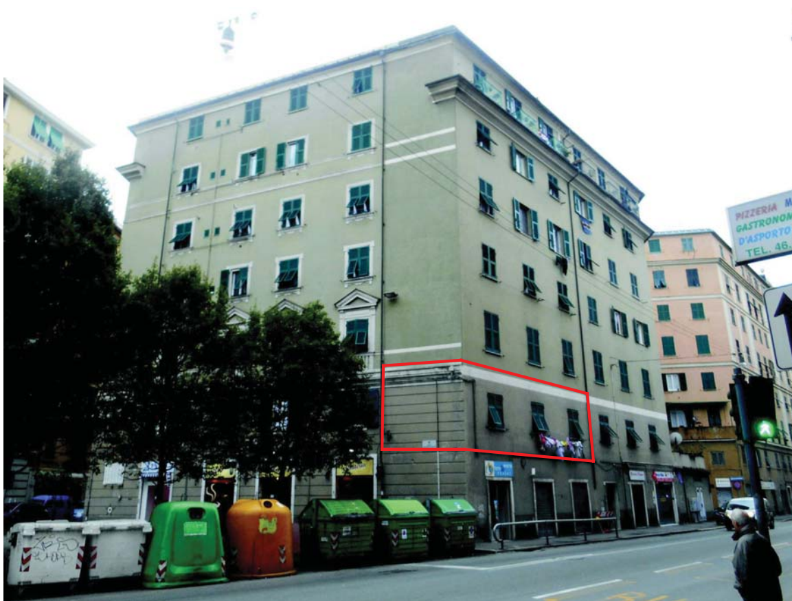
FOTO 2: Prospetto nord e nord-ovest
