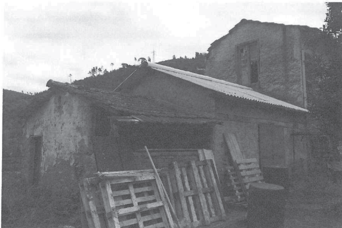
FOTO 5: VEDUTA GENERALE DELL'IMMOBILE OGGETTO DI STIMA — PROSPETTO NORD-OVEST
