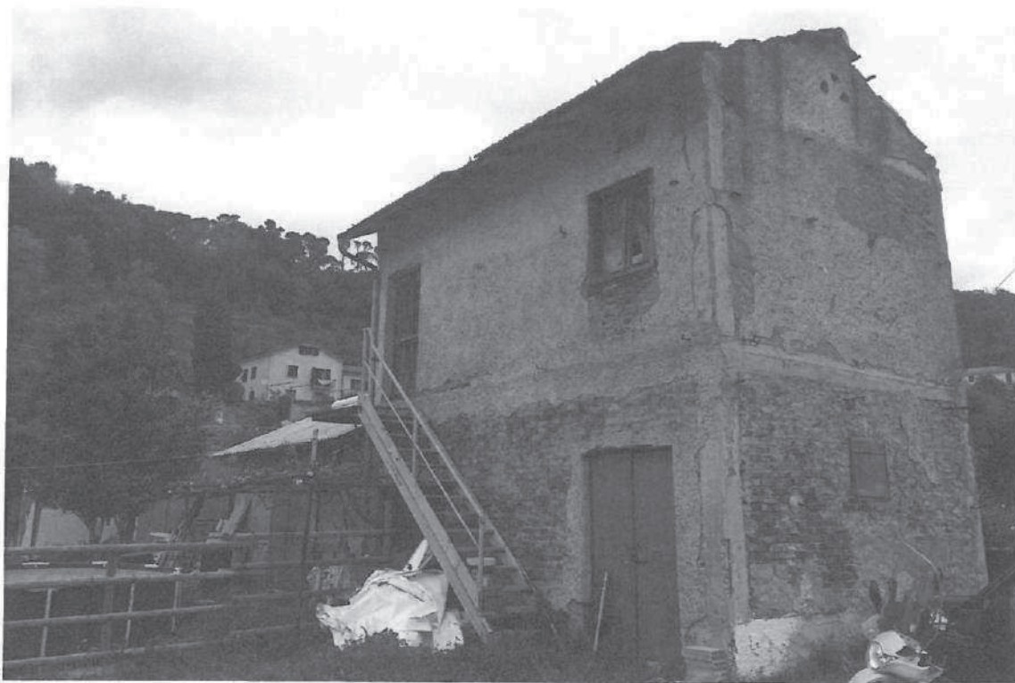
FOTO 3: VEDUTA GENERALE DELL'IMMOBILE OGGETTO DI STIMA - PROSPETTO SUD-OVEST
