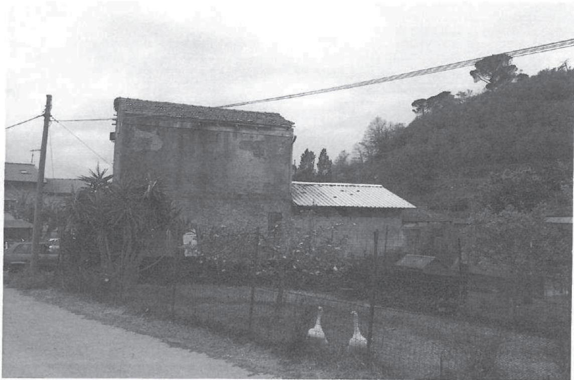
FOTO 1: VEDUTA GENERALE DELL'IMMOBILE OGGETTO DI STIMA – PROSPETTO EST
