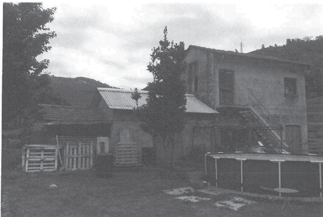
FOTO 4: VEDUTA GENERALE DELL'IMMOBILE OGGETTO DI STIMA - PROSPETTO OVEST
