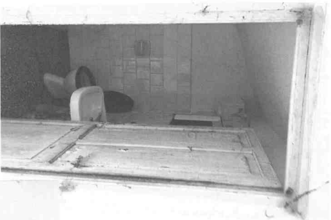
FOTO 25: BAGNO PIANO PRIMO
