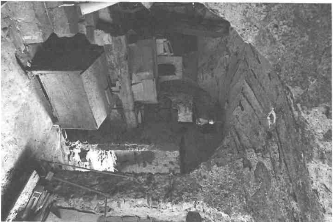
Foto 41: CANTINA PIANO TERRA
