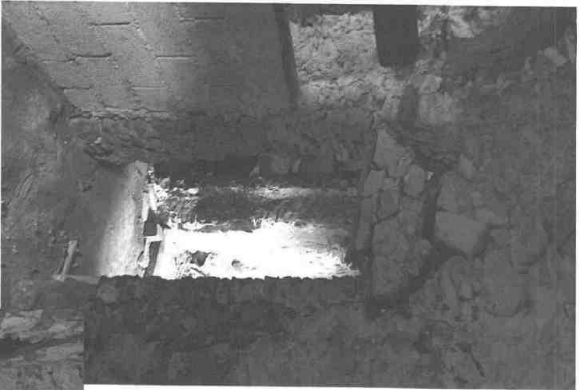
Foto 45: CANTINA PIANO TERRA
