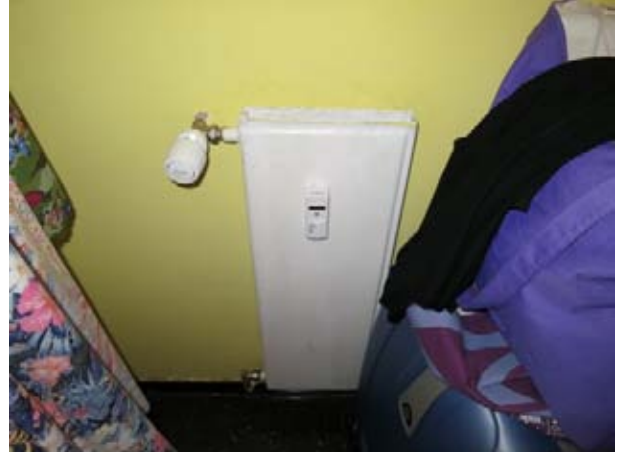
particolare termosifoni con installato contabilizzatore di calore e valvole termostatiche
