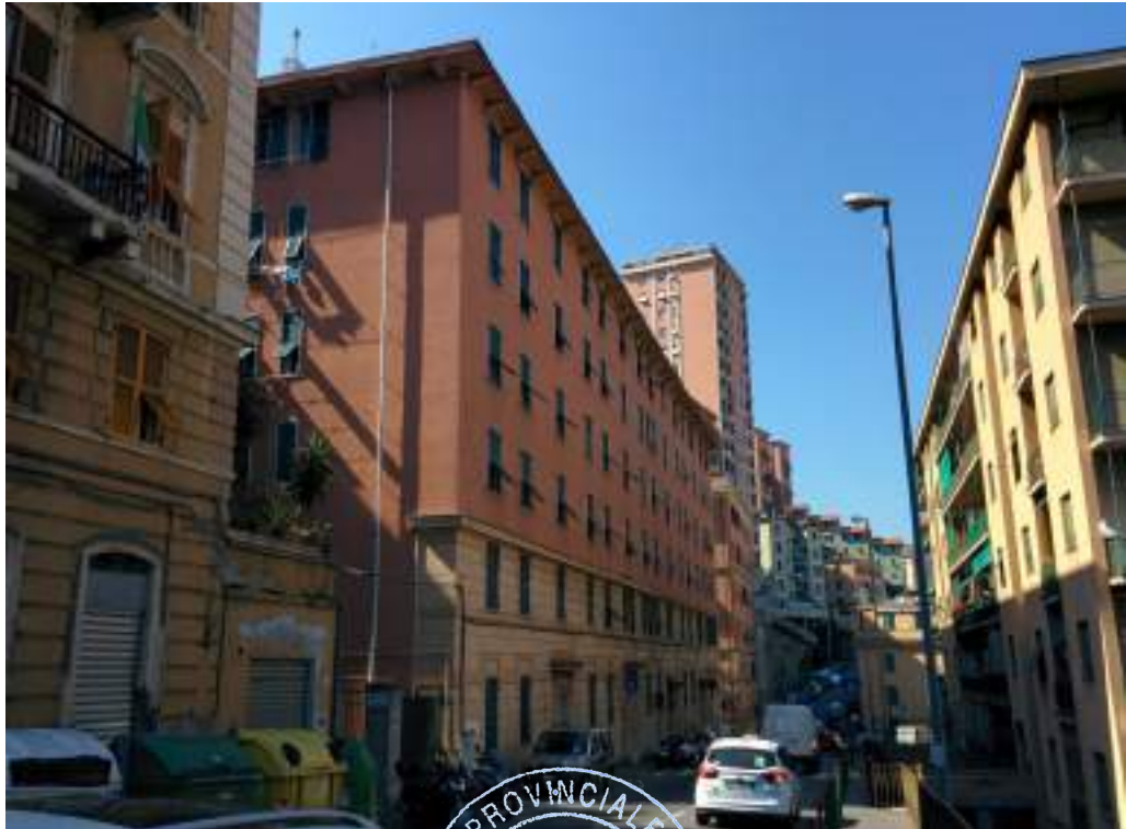
FOTO N°. 1: Prospetti Sud-Est
