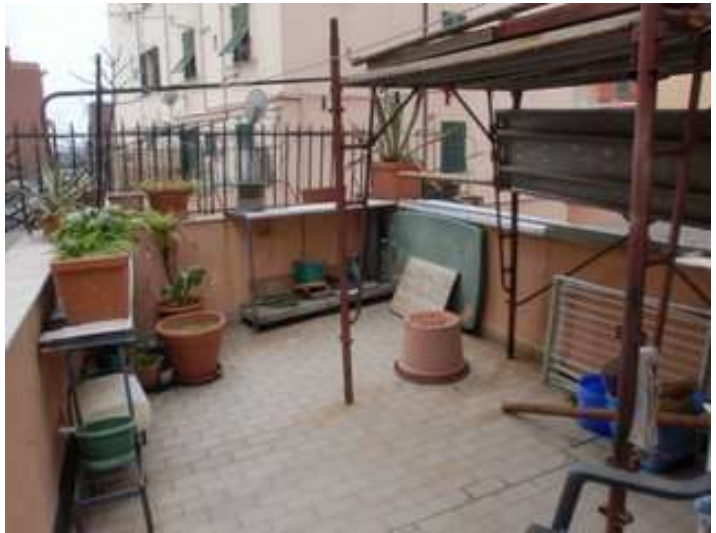
Foto n. 16 Porzione terrazzo Sud
