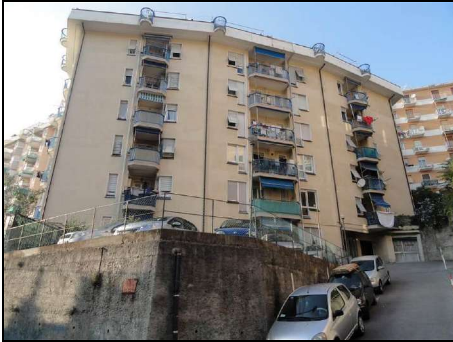
Foto 1: prospetto Est (principale)
