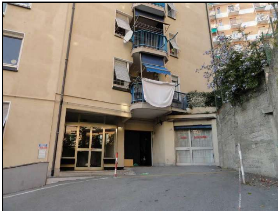
Foto 7: Vista dell'accesso al Condominio
