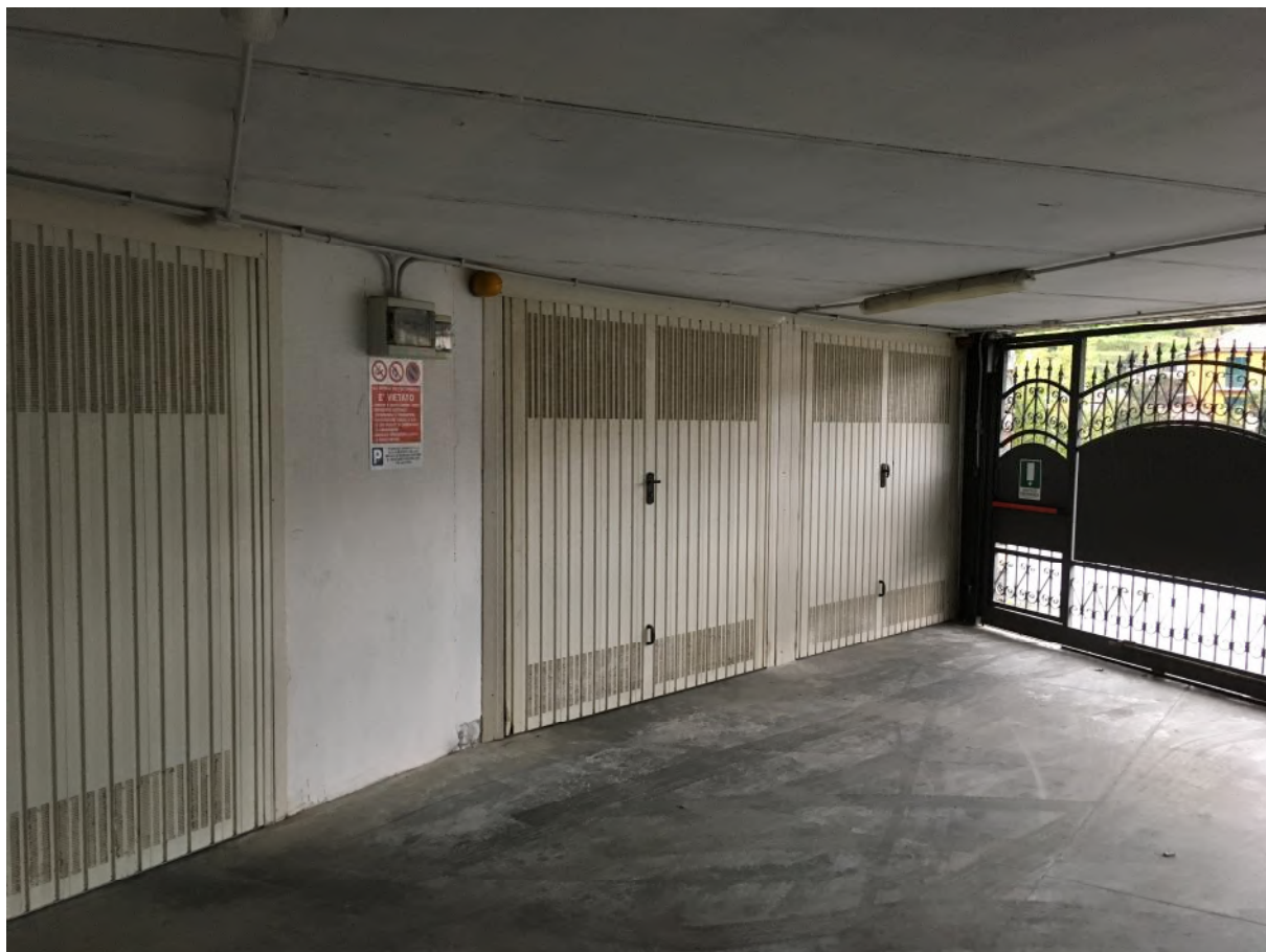
FOTO 13: serrande accesso box n. 44 (corpo B)
