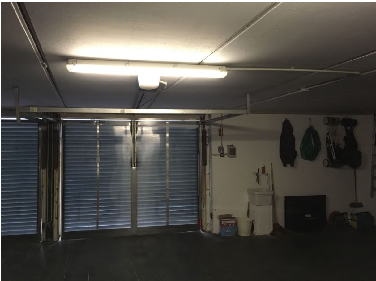
FOTO 16: interno box n. 44, lato serrande esterne (corpo B)
