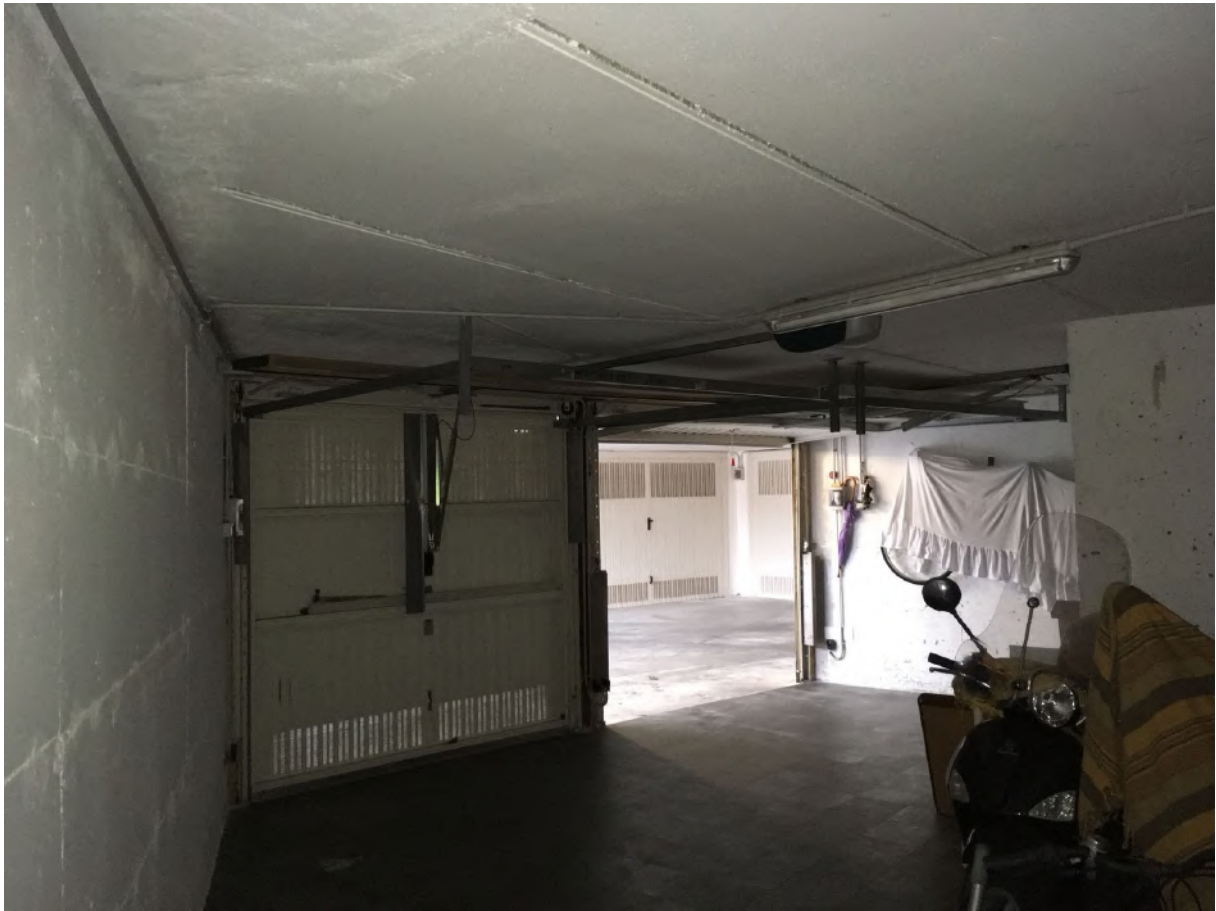
FOTO 15: interno box n. 44, lato serrande interne (corpo B)
