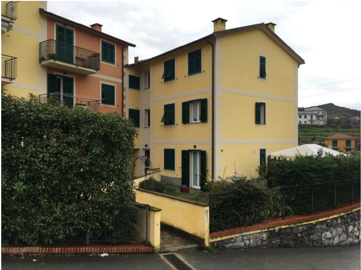
FOTO 3: prospetto nord del fabbricato civ.3B
