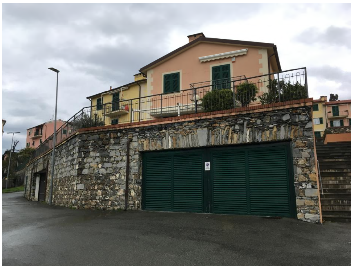
FOTO 14: accesso esterno al box n. 44 (corpo B)
