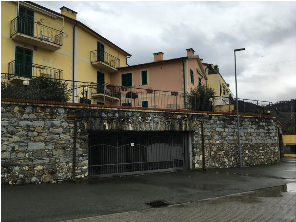
FOTO 12: accesso autorimessa contenente il box n. 44 (corpo B)
