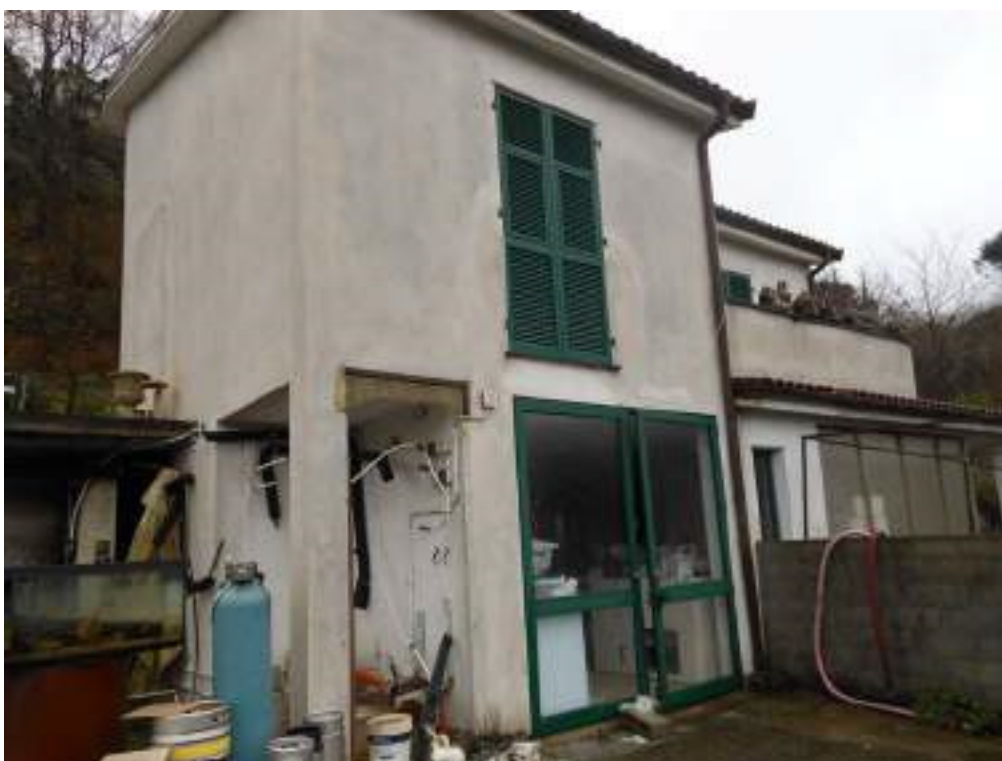
Fotografia n. 2 – vista esterna della casa
