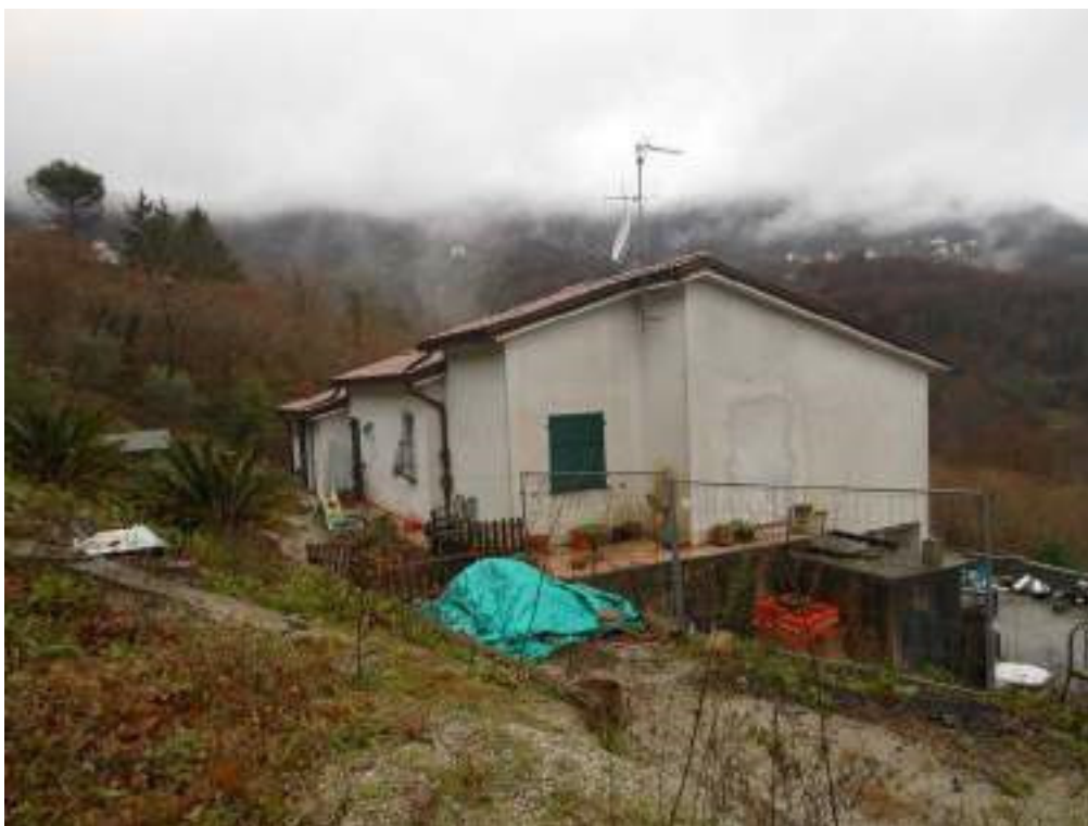
Fotografia n. 1 – vista esterna della casa
