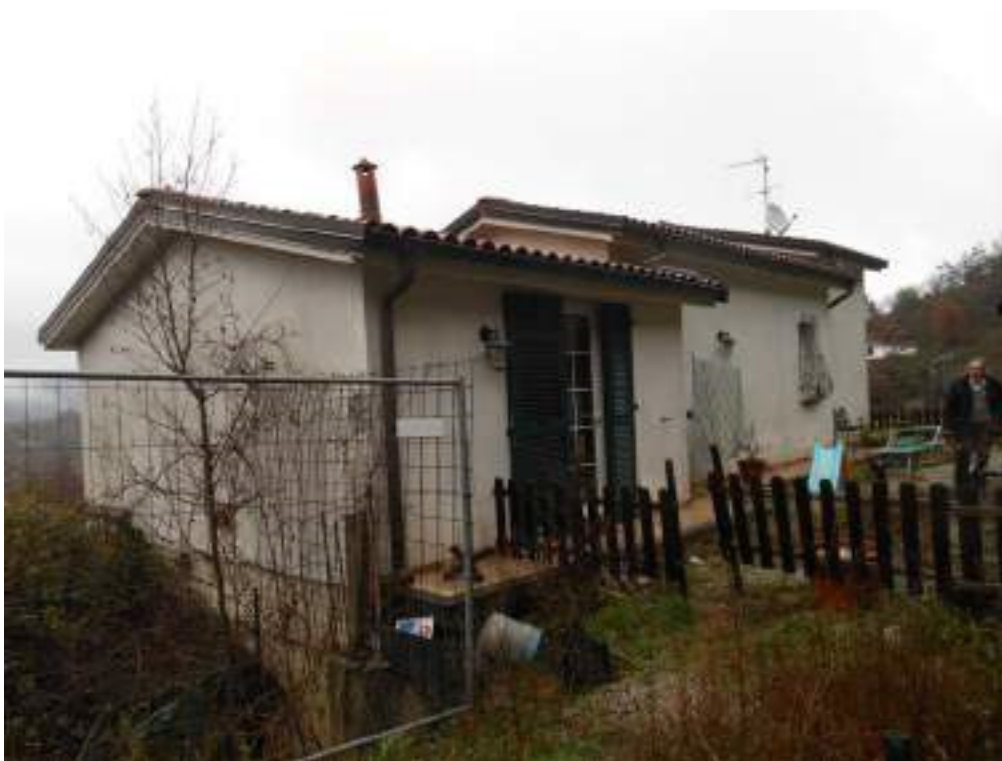
Fotografia n. 4 – vista esterna della casa
