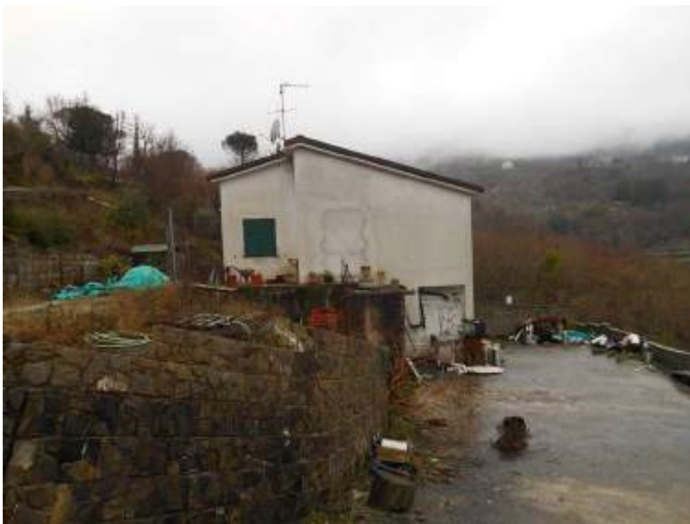
Fotografia n. 3 – vista esterna della casa
