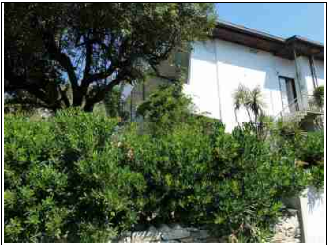
Foto 3 – particolare esterno immobile
