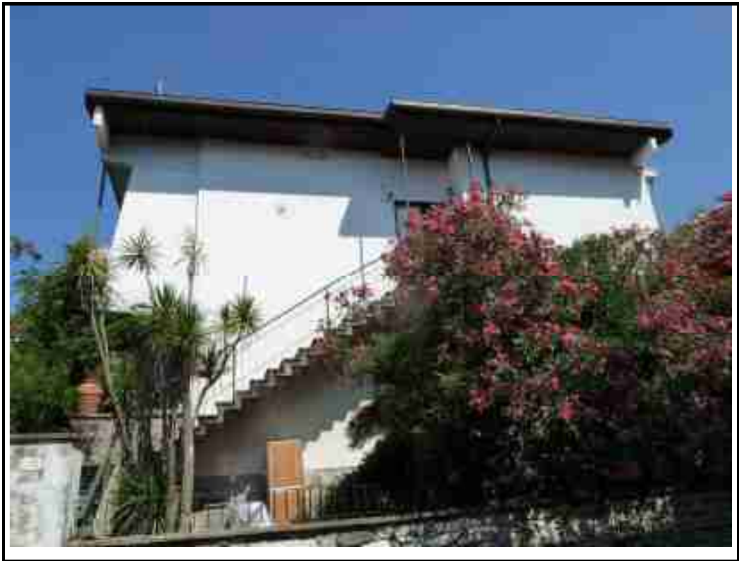
Foto 2 – particolare esterno immobile
