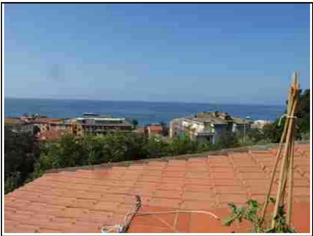
Foto 15 – particolare vista terrazzo a vasca sottotetto
