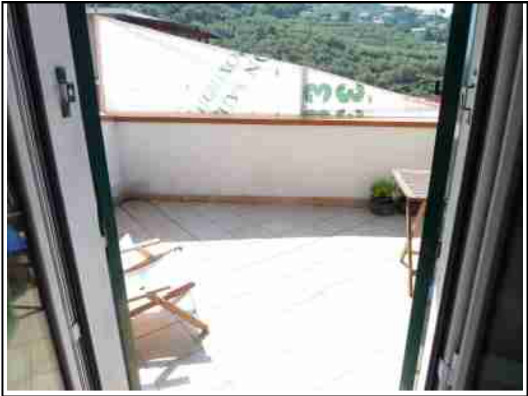
Foto 14 - particolare terrazzo a vasca sottotetto
