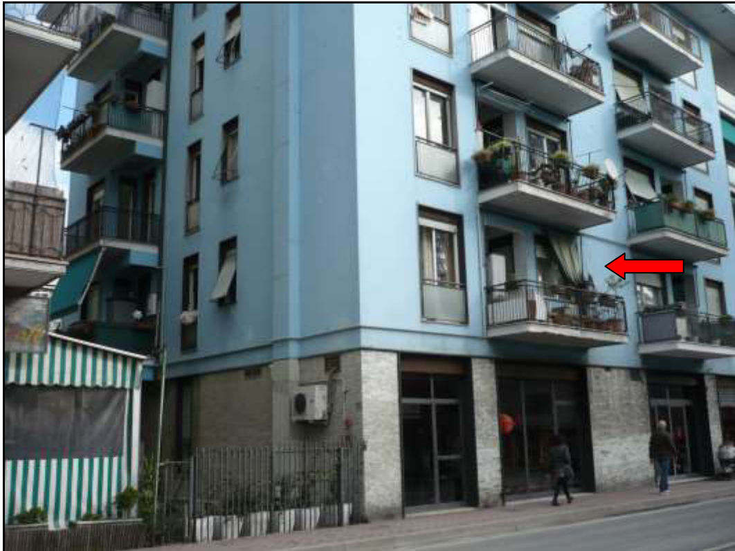
Foto n. 3 - Individuazione dell'appartamento, posto al piano primo.
