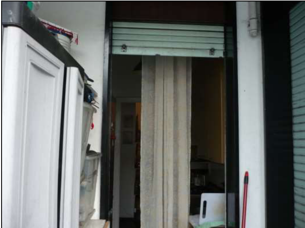
Foto n. 11 – Portafinestra della cucina.
