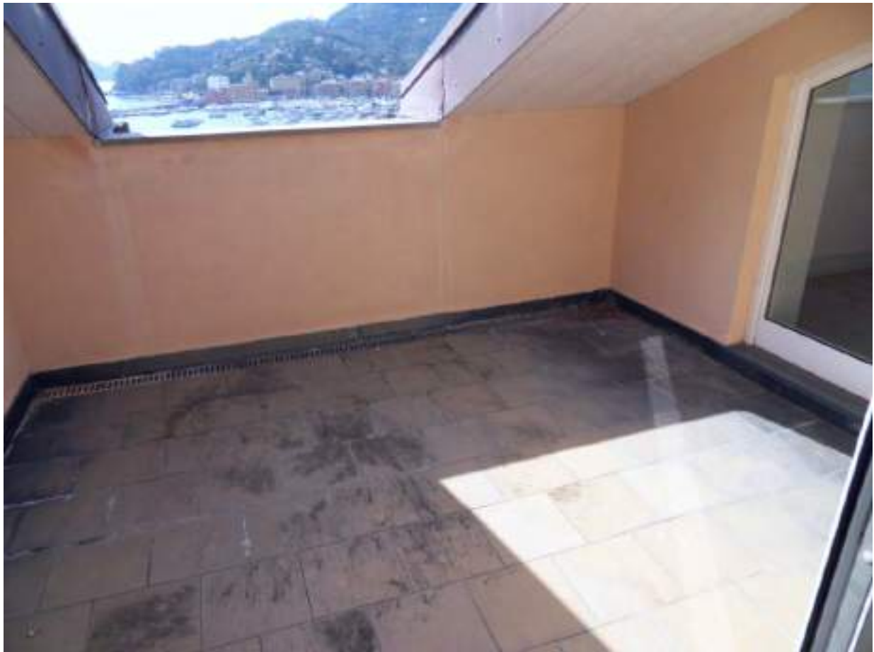
TERRAZZO INTERNO 7, PIANO TERZO
