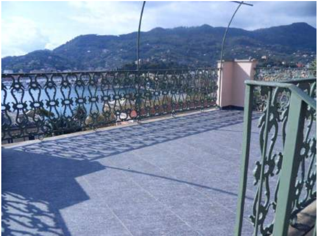
TERRAZZO DI COPERTURA INTERNO 6
