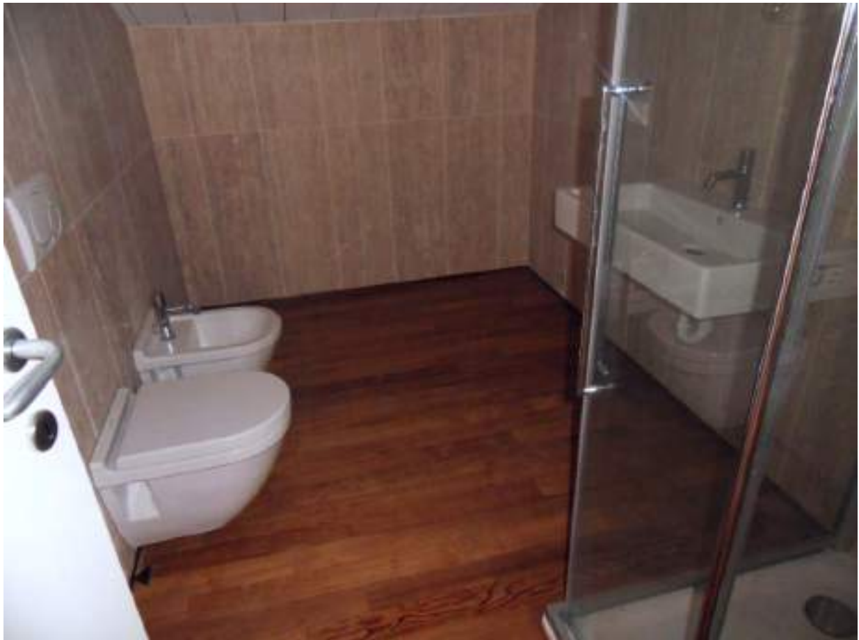
BAGNO INTERNO 7, PIANO TERZO
