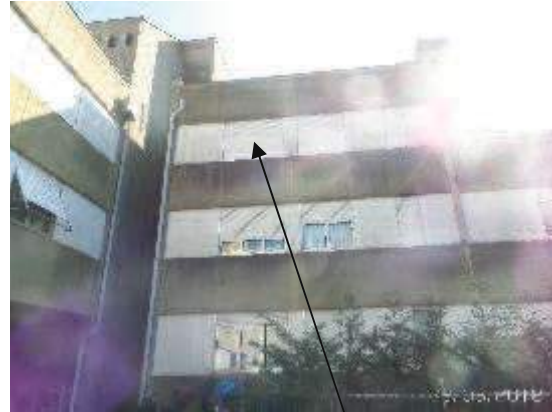
Foto 22: Prospetto Nord (finestra difforme dal progetto)
