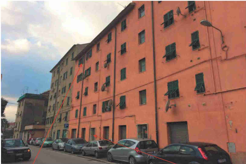
VISTA D'INSIEME FABBRICATO ingresso civico 26 appartamento civico 26/7
