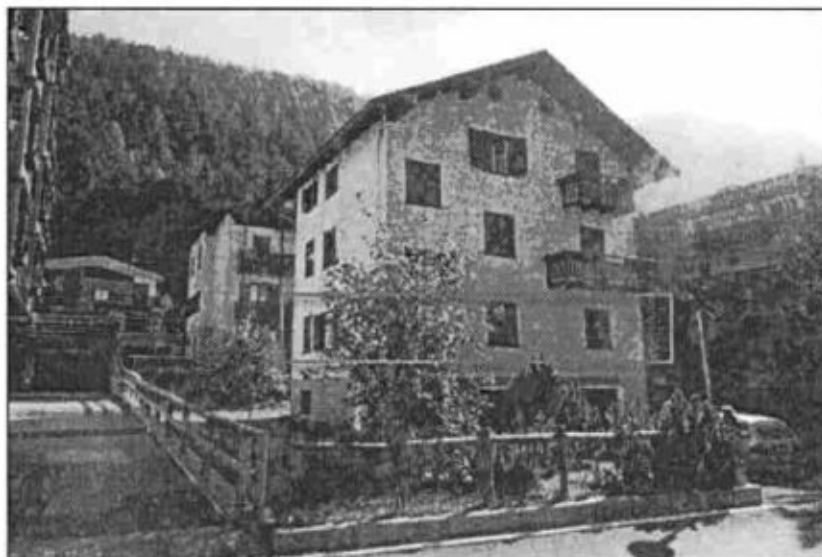
foto esterna da Via Valfesinella
