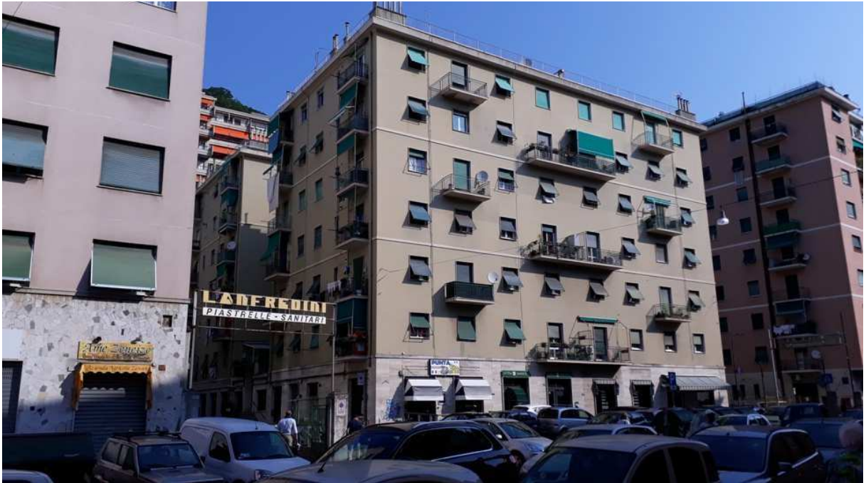
Vista generale fabbricato Via Piacenza civici 130-132 - Fotografia n° 1
