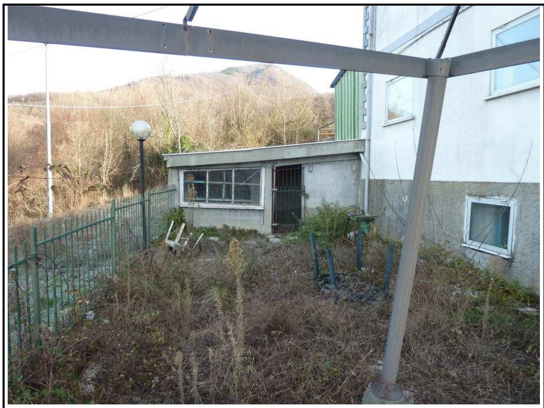
Foto 17 – particolare manufatto in muratura (rimessa in pristino)
