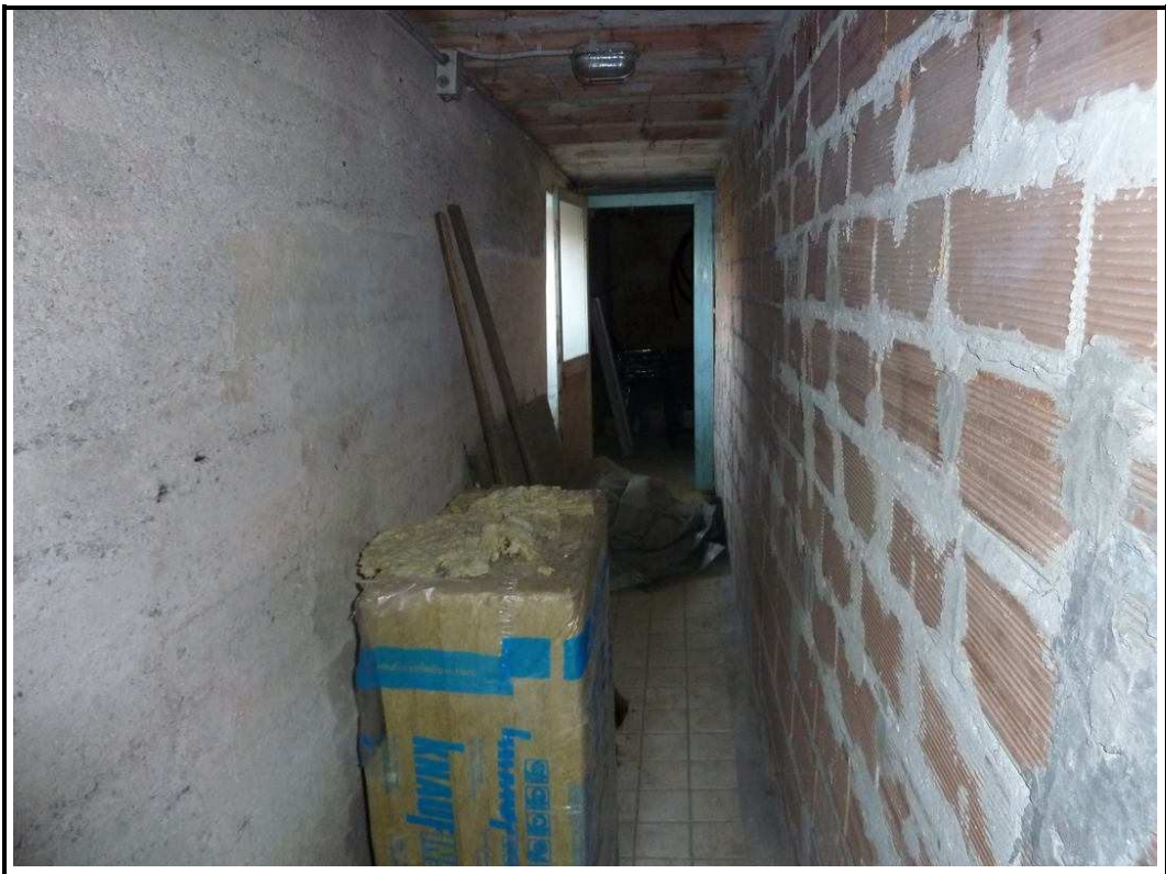
Foto 15 – particolare corridoio cantina
