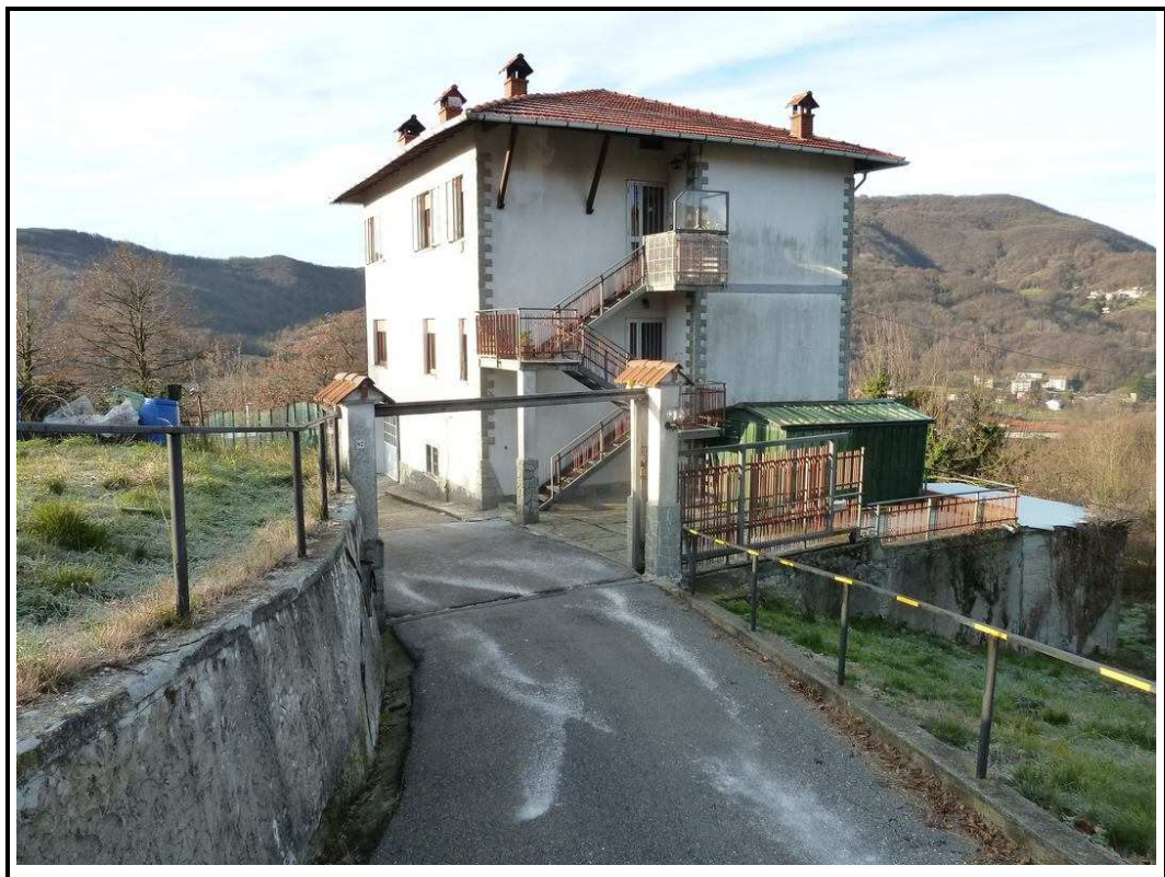
Foto 1 – particolare accesso edifico bifamiliare
