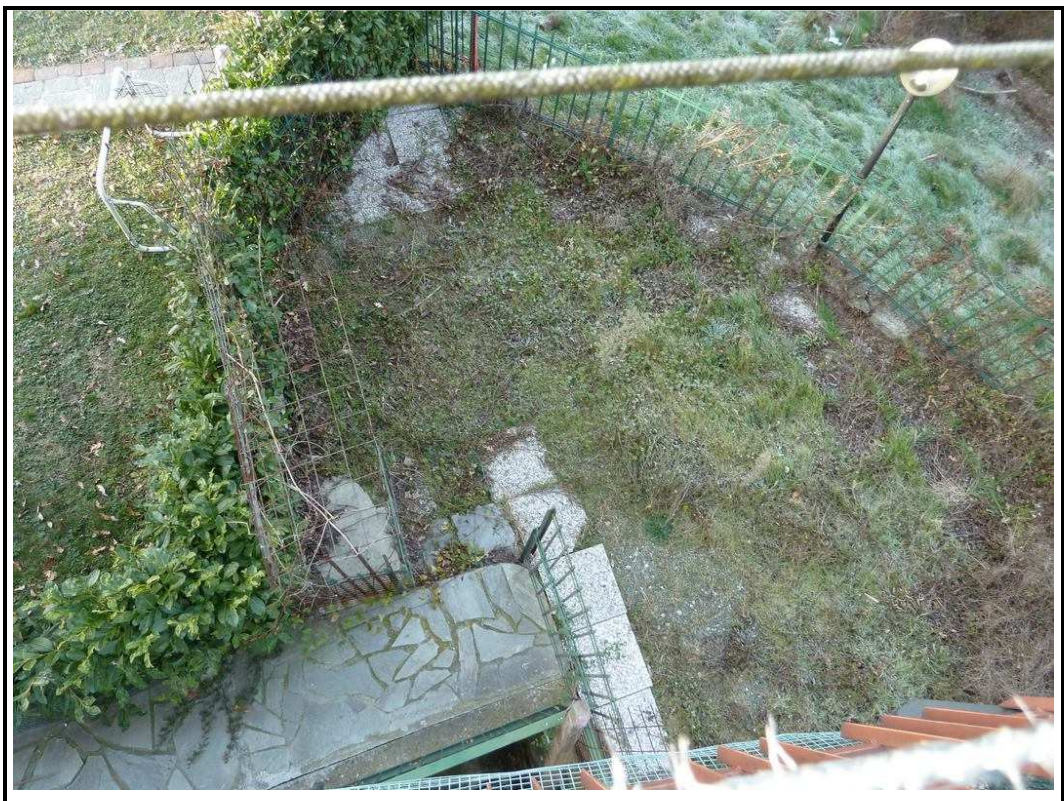
Foto 11 – particolare giardino di proprietà
