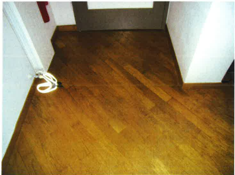
Foto 3 – particolare della pavimentazione
