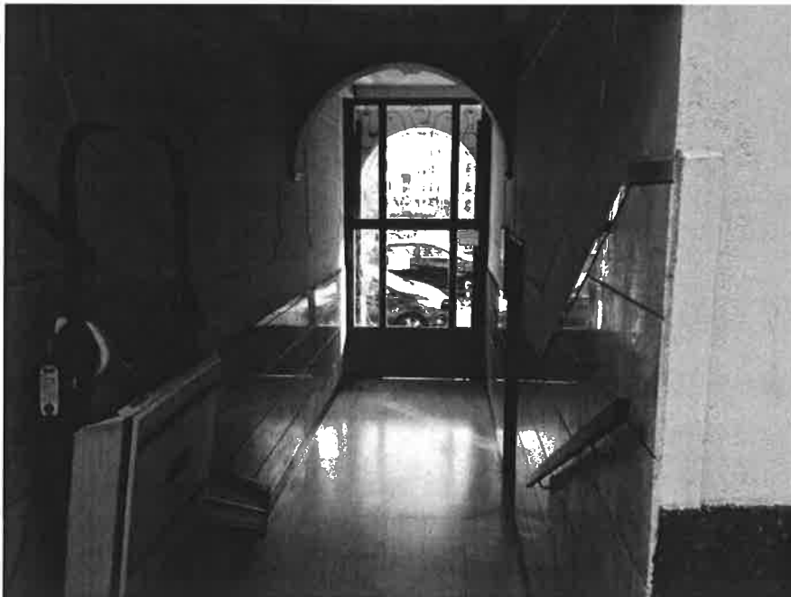
Foto n° 4 – Vista interna atrio vano scala immobile
