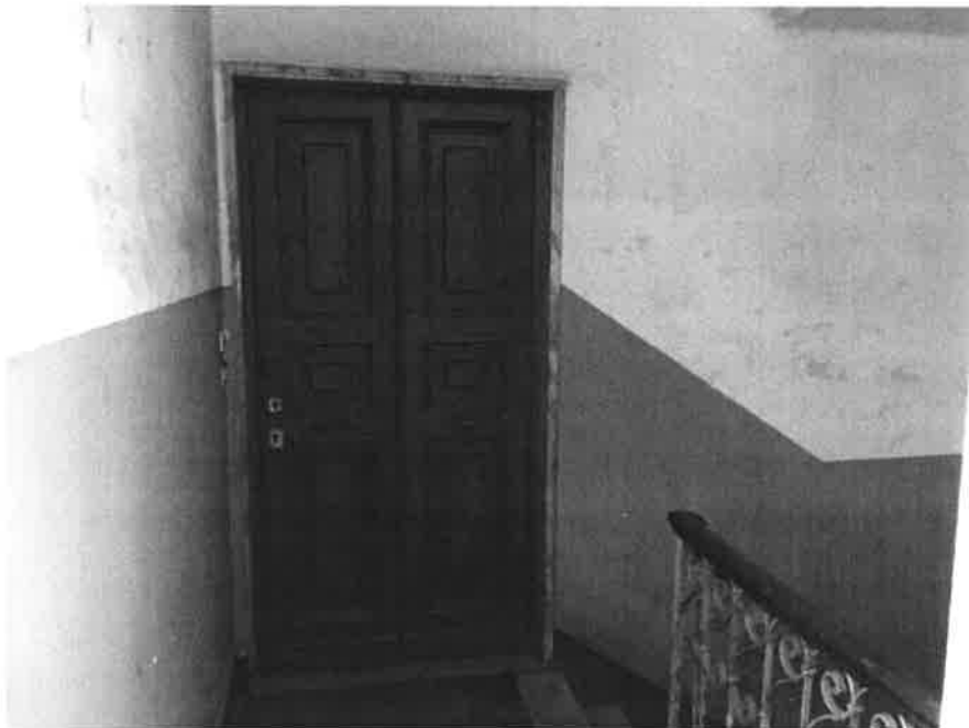
Foto n° 6 – Vista portoncino caposcala accesso appartamento
