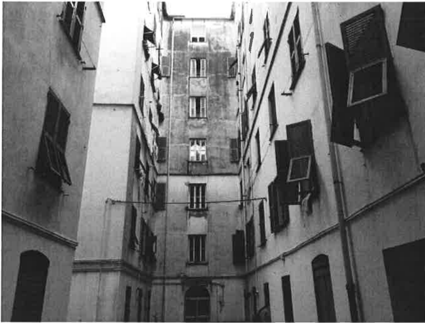
Foto n° 3 – Vista esterna accesso condominio scala D
