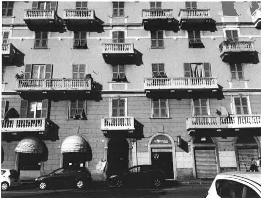
Foto n° 2 - Vista esterna accesso immobile pluricondominiale
