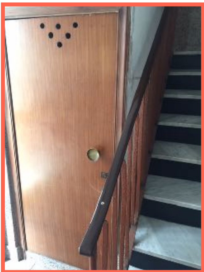
Foto 10 - porta accesso ripostiglio al piano terra
