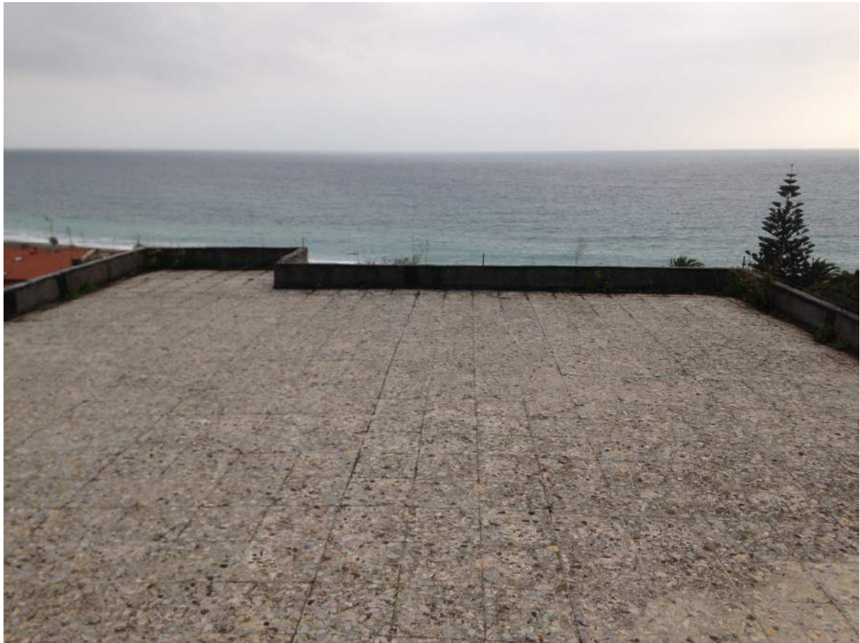
FOTO 9: lastrico solare (vista verso sud)
