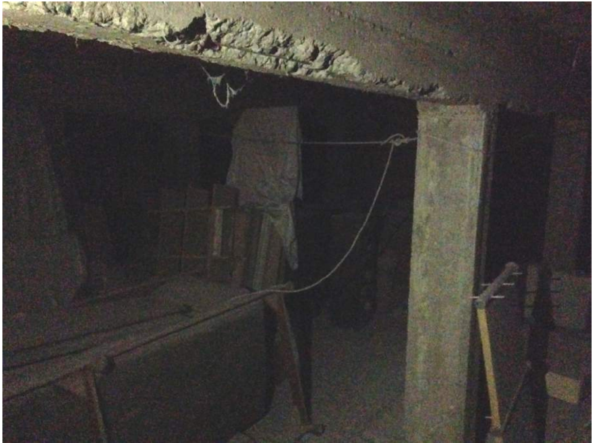
FOTO 7: interno locale sottotetto
