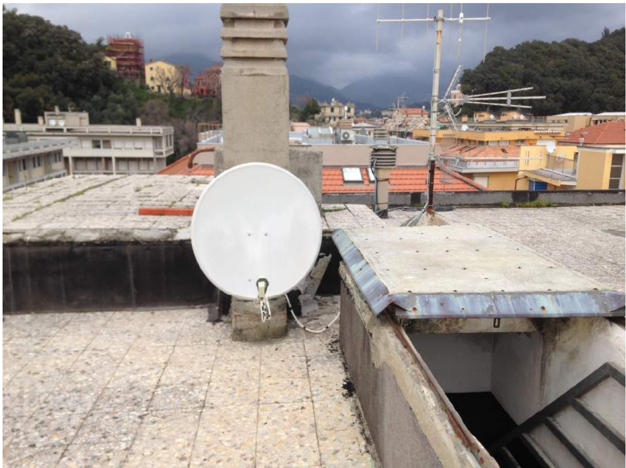
FOTO 8: lastrico solare (accesso, vista verso nord)
