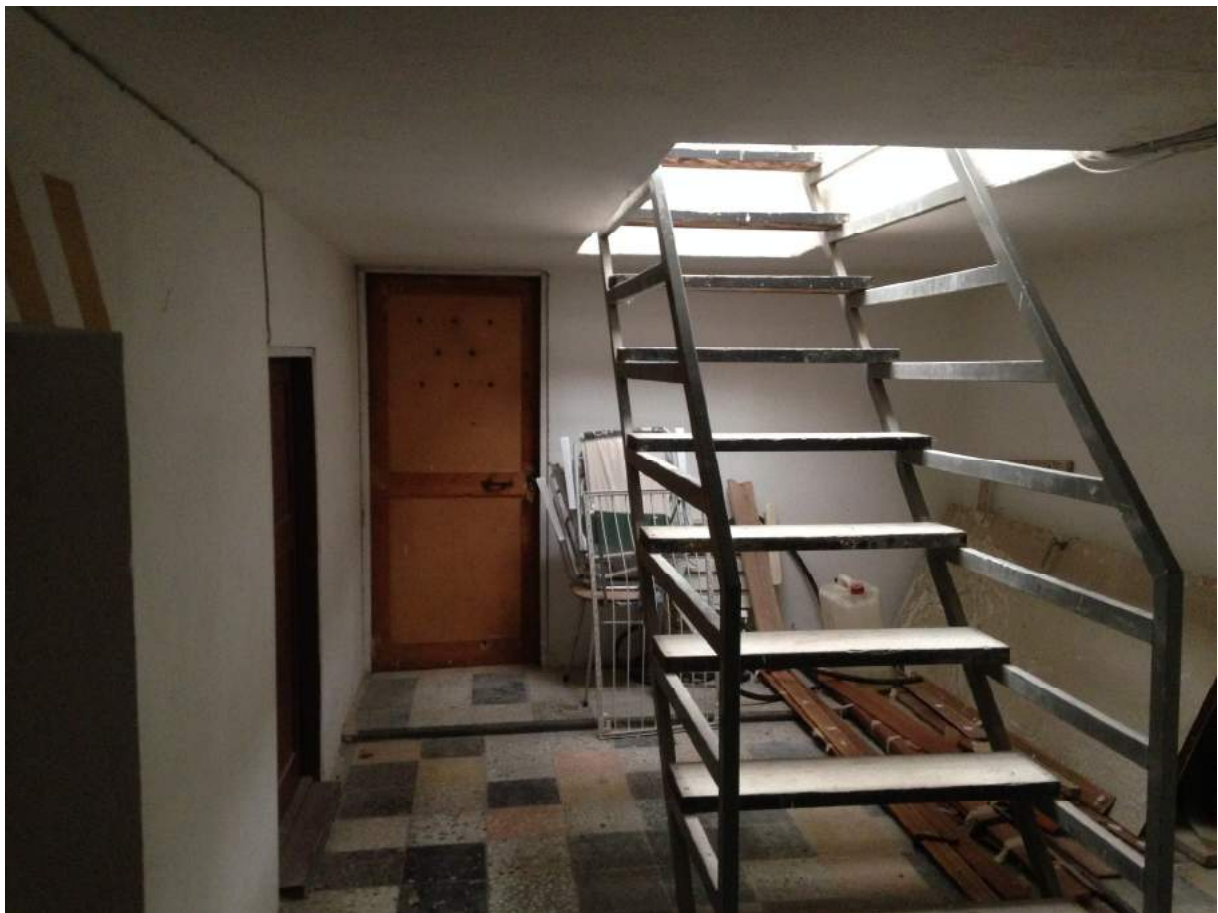
FOTO 4: area comune piano sottotetto e scala accesso al lastrico solare di pertinenza
