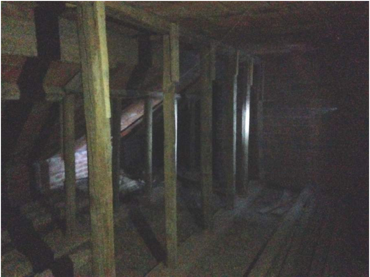
FOTO 5: interno locale sottotetto
