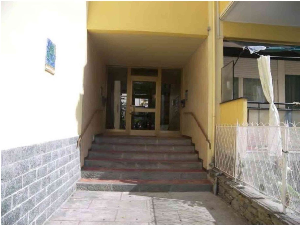
Foto 2 dettaglio ingresso al Condominio
