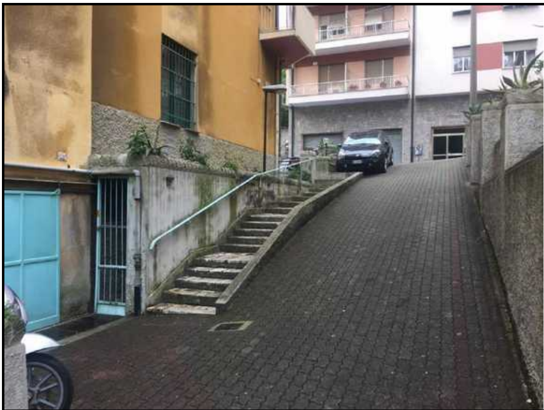
Foto 2 – rampa di accesso
