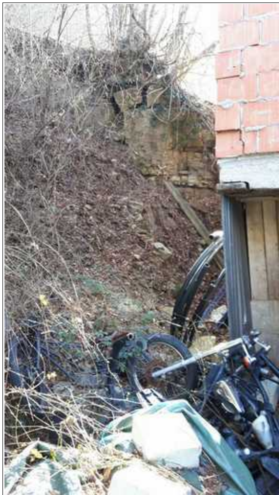
Frana su perimetrale in pietra a Nord-Est
