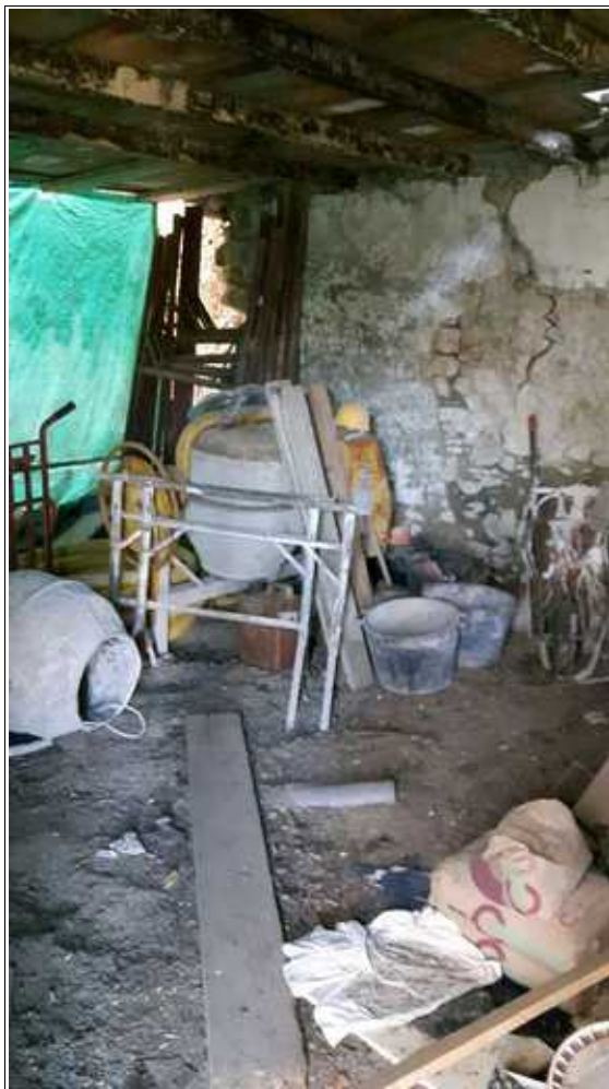
Sulla sinistra perimetrale demolito dalla frana
