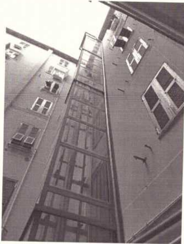
FOTO 7—PARTICOLARE ASCENSORI ESTERNI (UNO PER OGNI SCALA)
