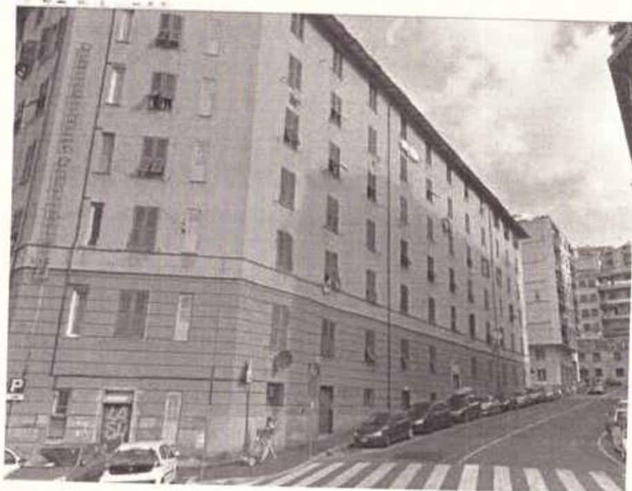
FOTO 3—PROSPETTO SU VIALE BRACELLI
