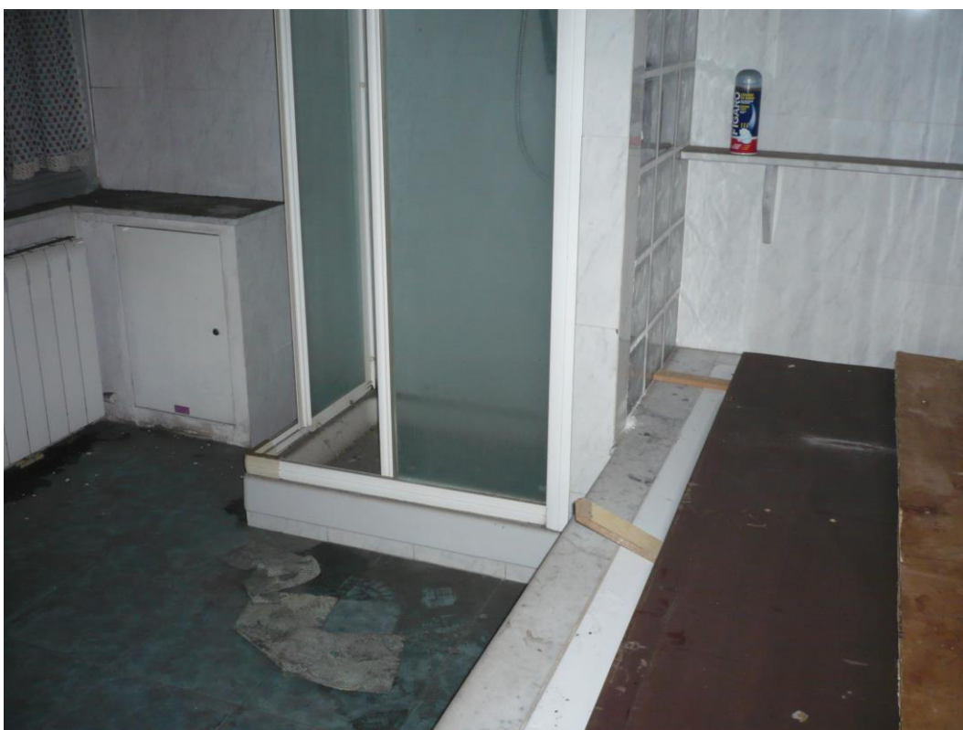
Foto n. 10 – Locale bagno dotato di piatto doccia e di vasca da bagno.
