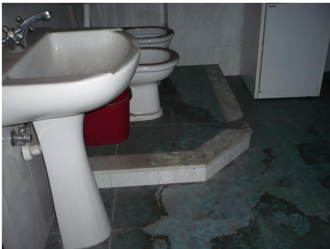
Foto n. 9 - Locale bagno, porzione di pavimento rialzato con il gradino.
