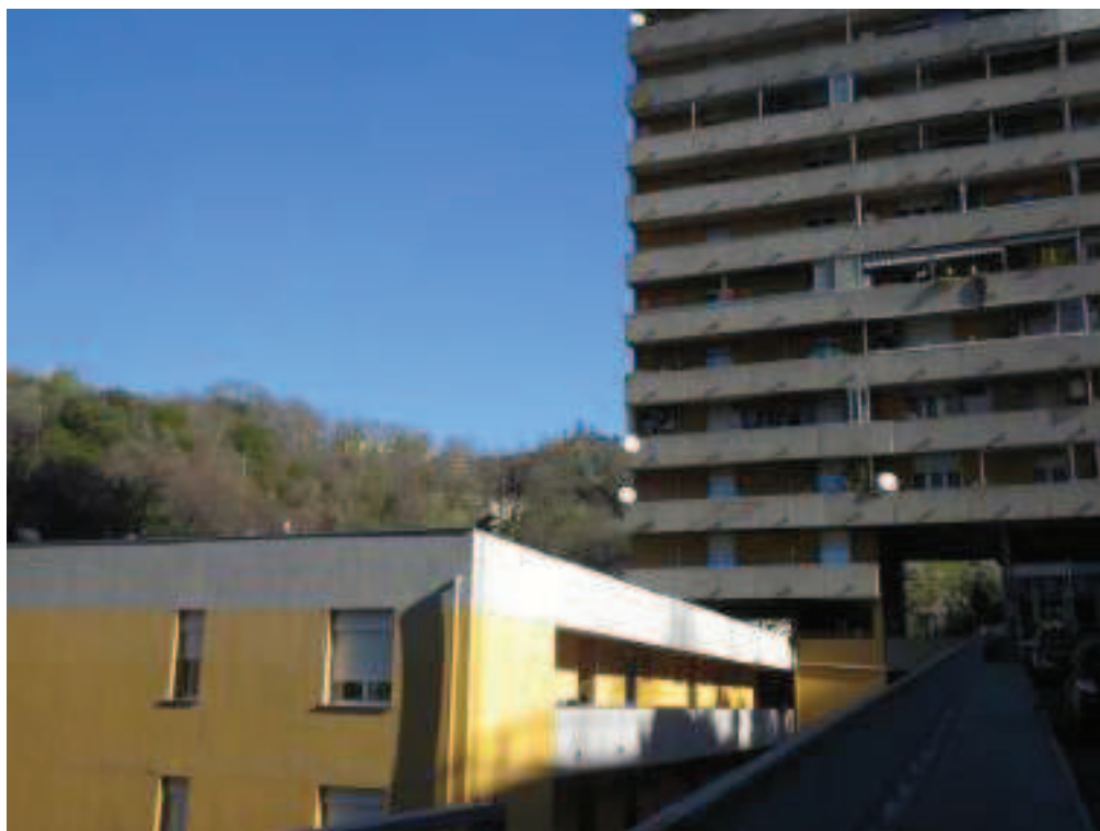
Fotografia n. 1 – vista esterna del complesso
