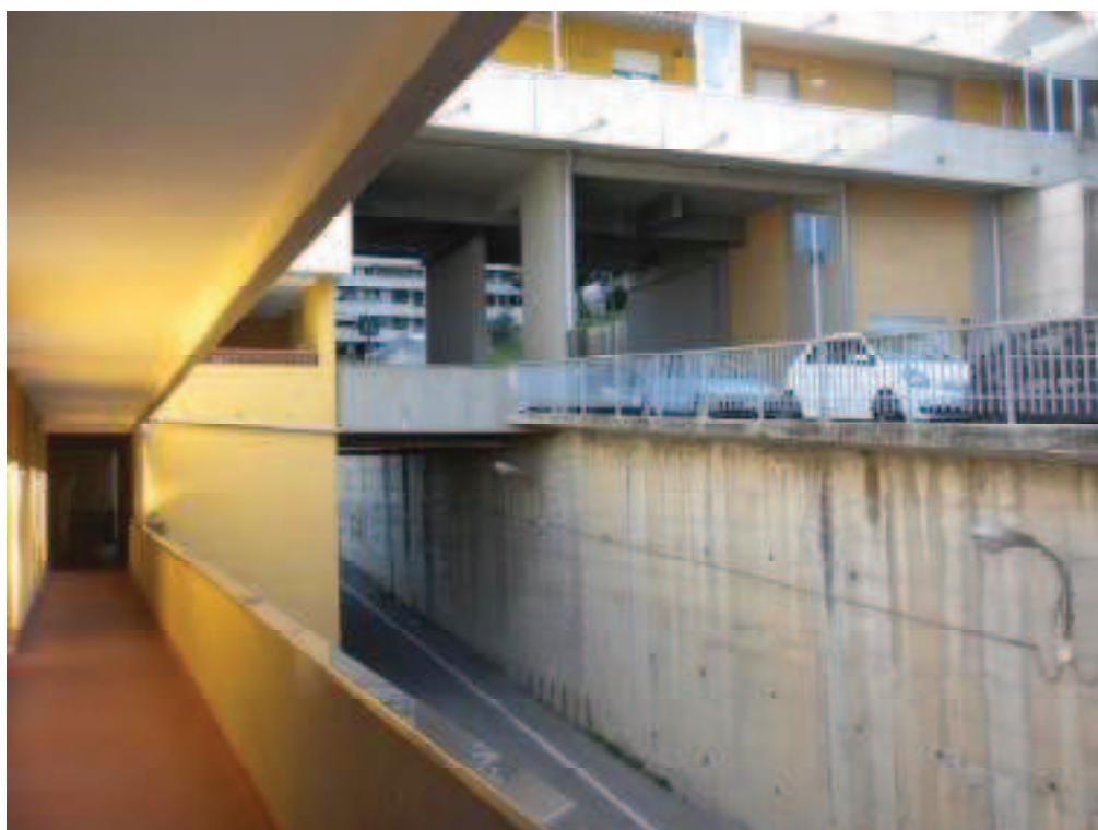
Fotografia n. 4 – corridoio d'accesso all'abitazione
