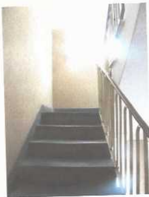
FOTO 4 - rampa verso il primo piano
