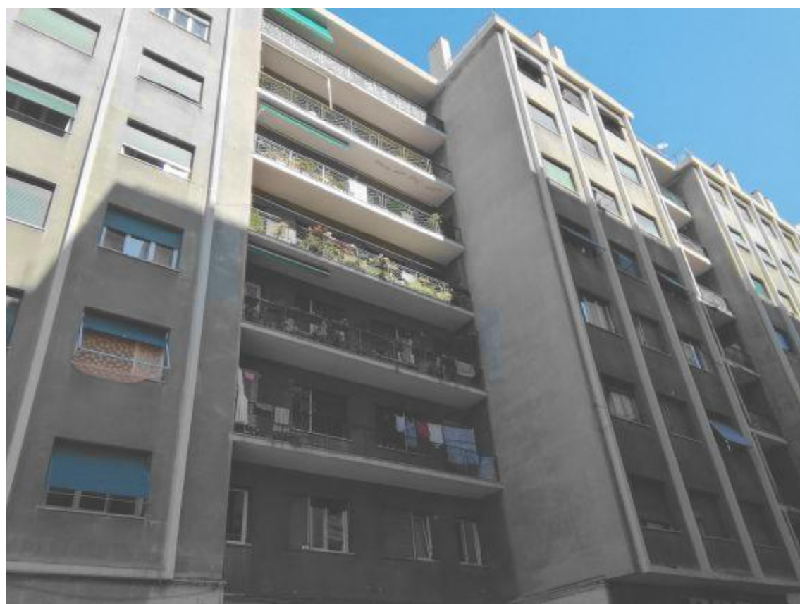
FOTO N° 1-2 - CONDOMINIO VIA LA SPEZIA CIVV. 4-6- GENOVA
