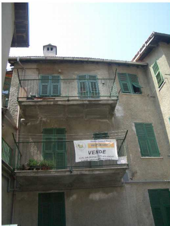
03 - Facciata su Largo Pizzorni
