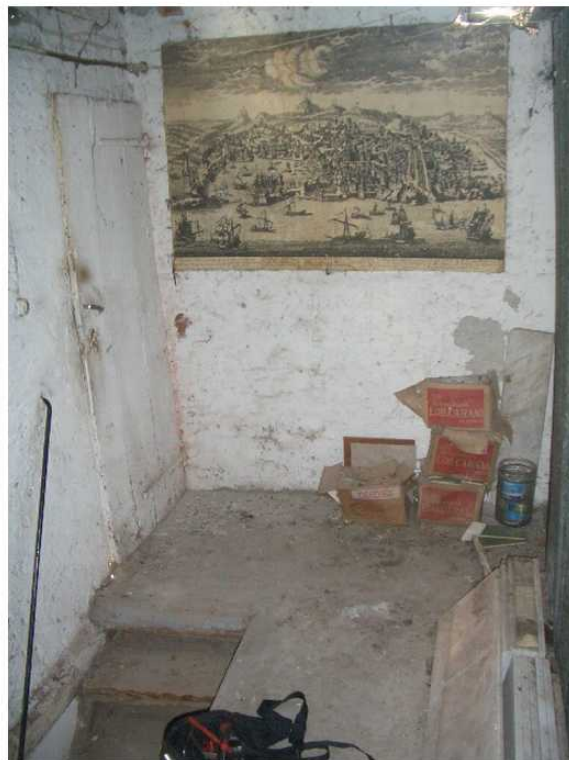
26 - Accesso al sottotetto
