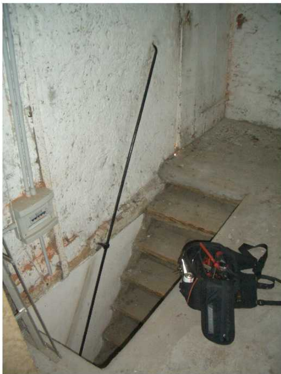
25 - Accesso al sottotetto
