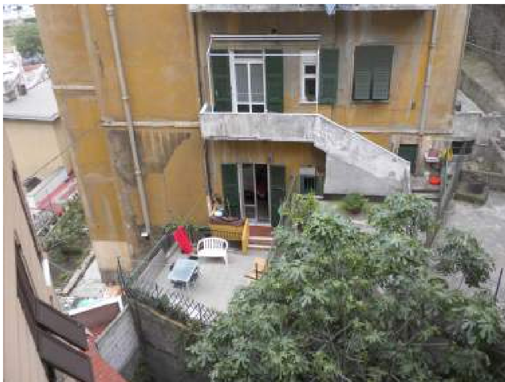
Fotografia n. 3 – vista esterna dell’abitazione
