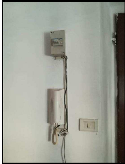
Foto 24: dettaglio impianto elettrico
