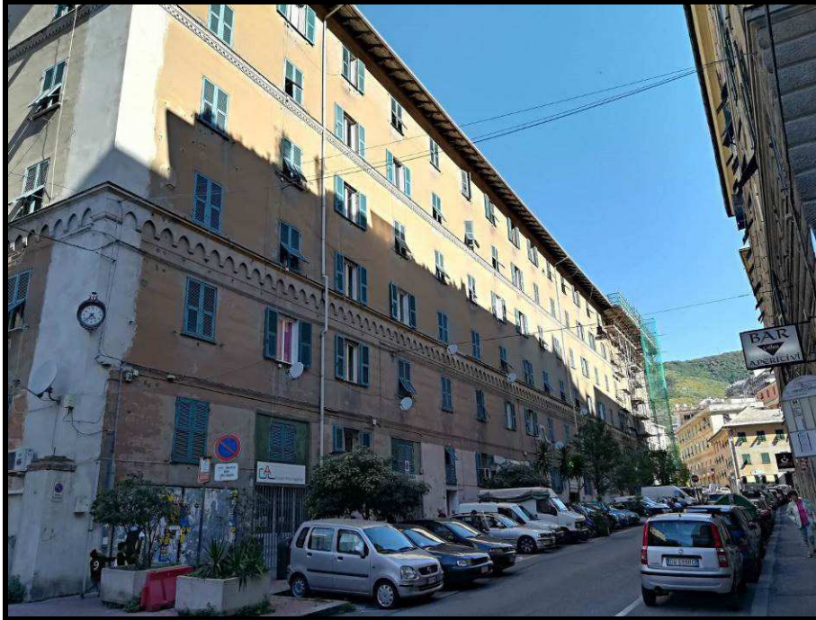
Foto 1: Prospetto Ovest (Via del Lagaccio)
