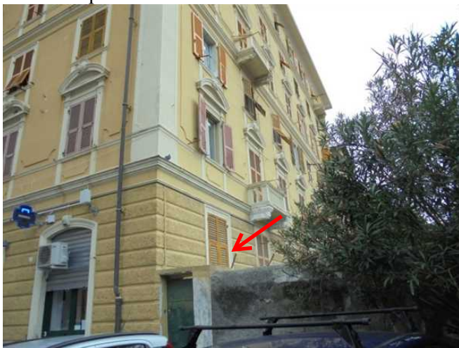
Foto 4 Angolo Sud/Ovest e Prospetto Sud/ ferrovia, affaccio dell'int. 2
