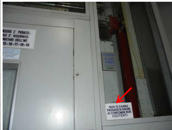
Foto 11 Limitazione d'uso dell'ascensore
