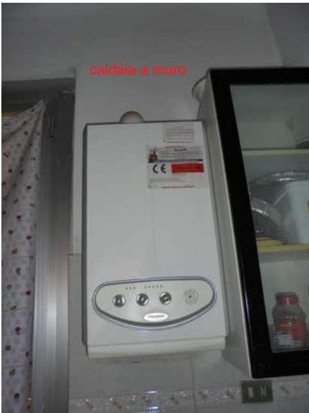
Foto 19/20 Caldaia a gas metano in cucina
