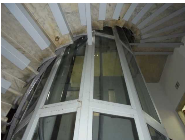
Foto 12 Vano corsa ascensore e rinforzi in acciaio della scala. Foto 13 Portoncino caposcala
