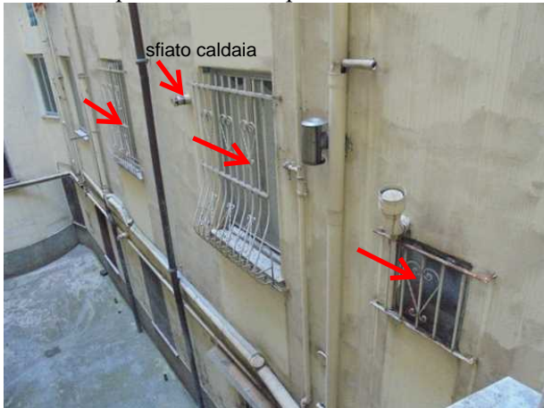
Foto 10 Cavedio visto dal vano scale, affaccio int. 2.
