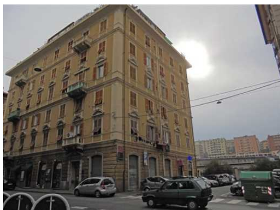
Foto 2 Prospetti Nord su via G. Torti e Ovest
