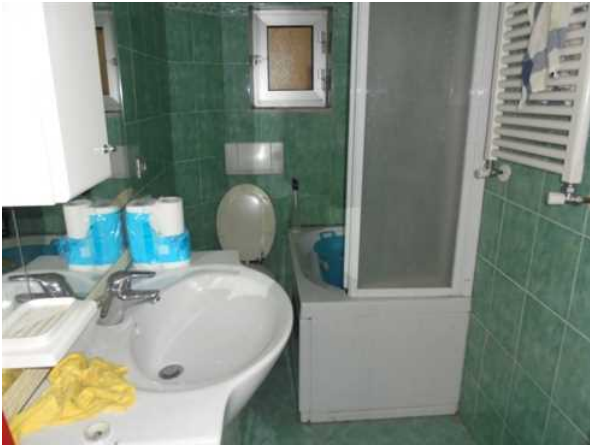
Foto 17 Bagno con finestra sul cavedio
