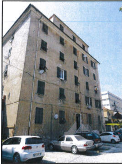
Foto 1: prospetto Est (principale) dell'edificio
