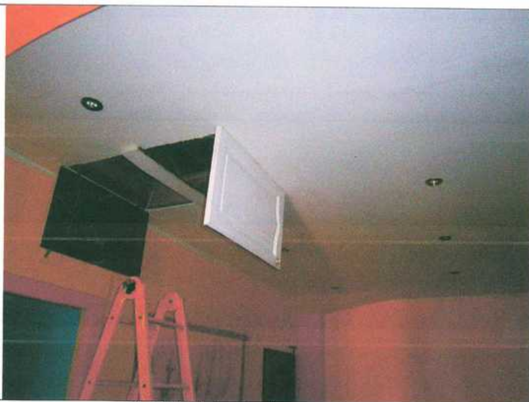
Foto 12: Particolare botola accesso al sottotetto
