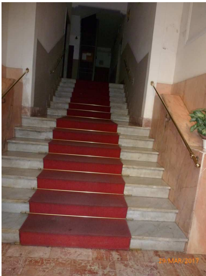
SECONDA SCALA DAL PORTONE ALLA QUOTA CAVEDIO
