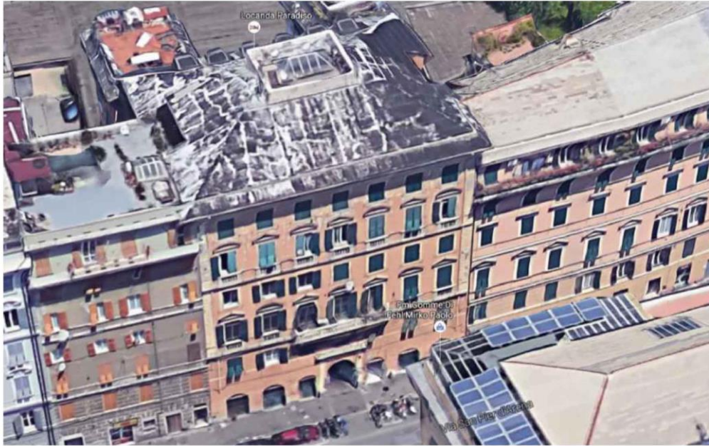
Figura 4 – Vista aerea della zona con indicazione del fabbricato
