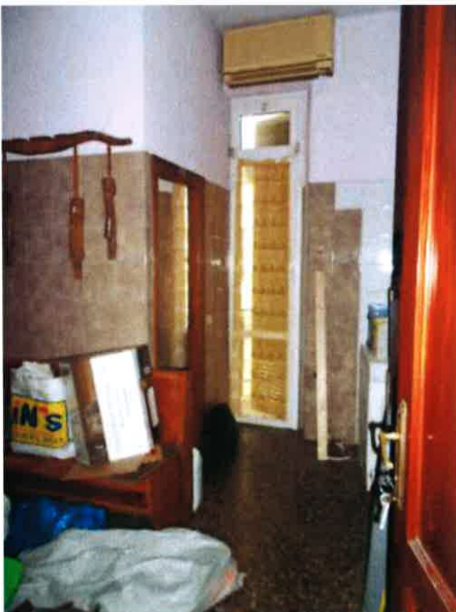
FOTO N°7 e 8 Magazzino e locale caldaia
