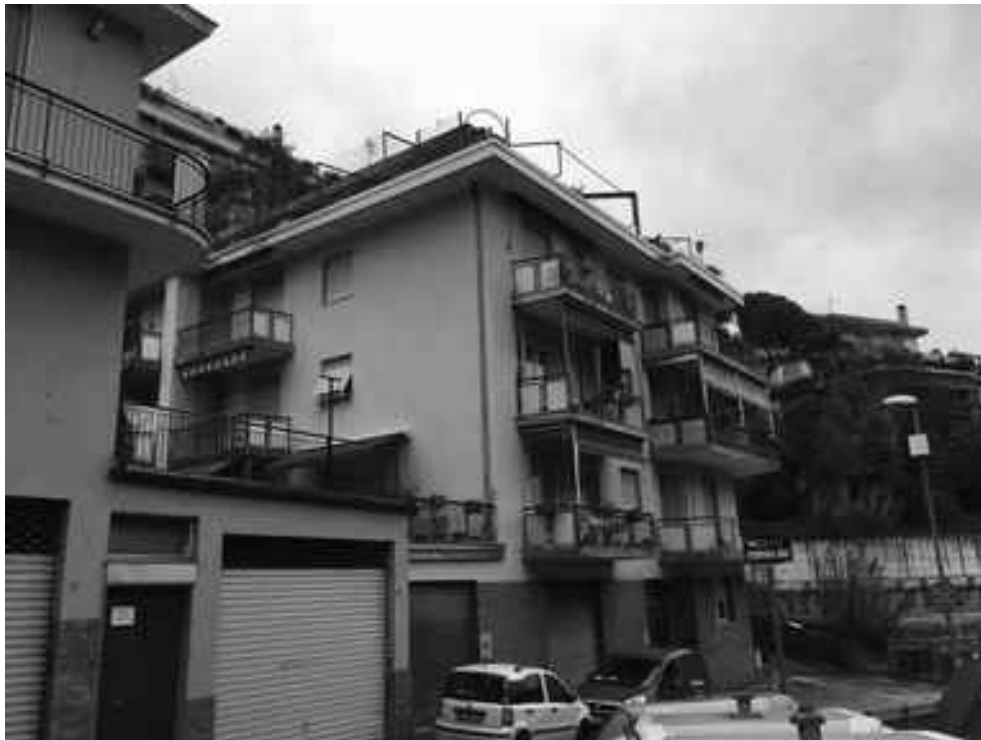
Foto n°1 – Vista esterna immobile civ. 90 di Via Laggiaro, in Rapallo (GE)
