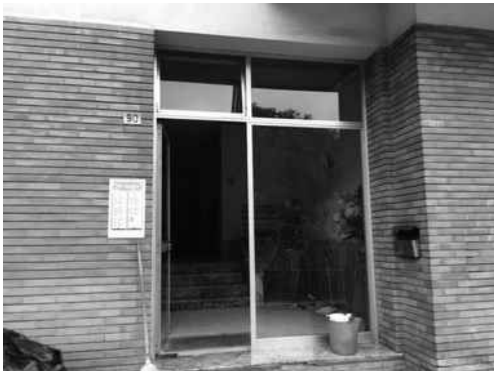
Foto n°3 – Accesso condominiale immobile civ. 90 di Via Laggiaro, in Rapallo (GE)
