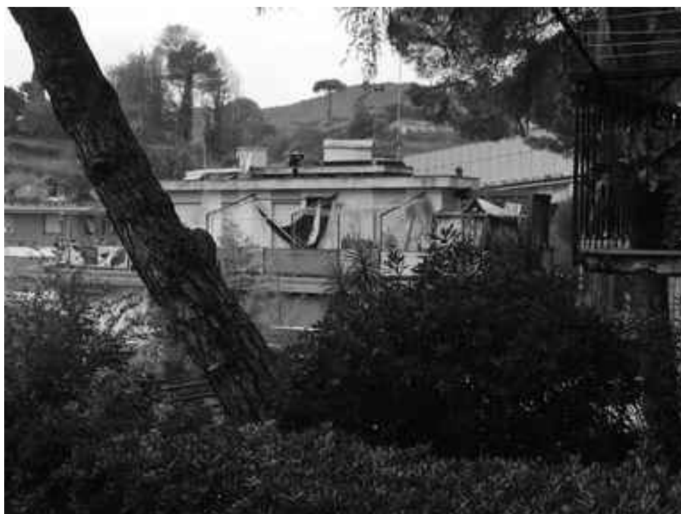
Foto n°6 – Vista esterna porz. attico civ. 90\19 di Via Laggiaro, in Rapallo (GE)
