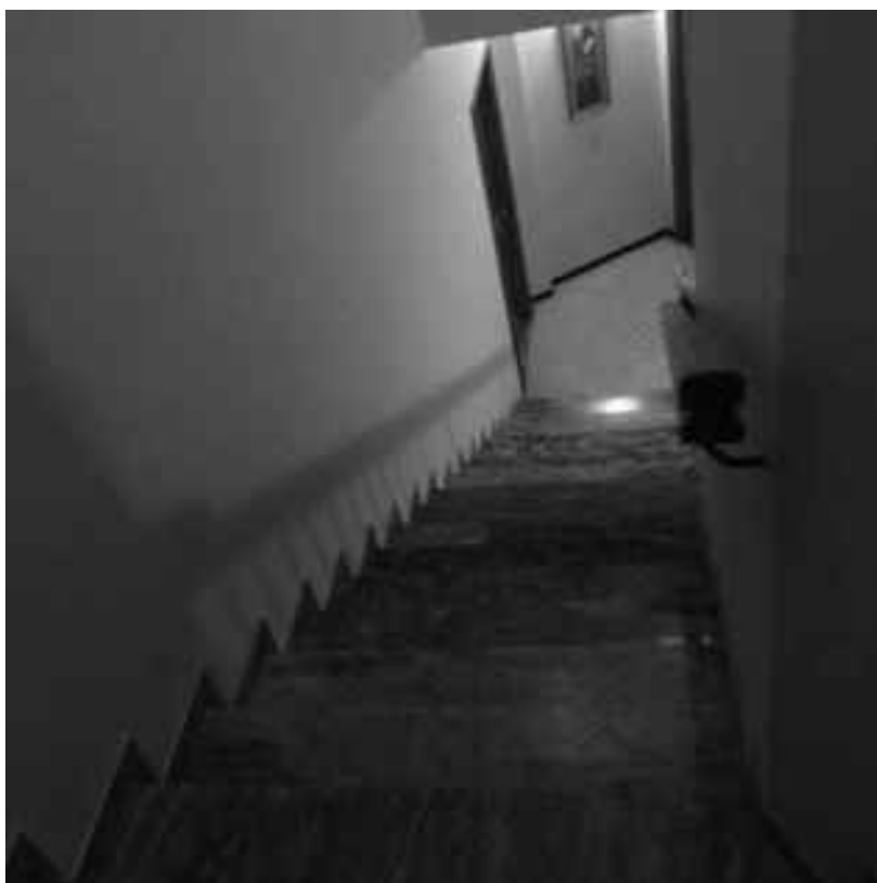
Foto n°4 – Vista interna scale condominiali civ. 90 di Via Laggiaro, in Rapallo
