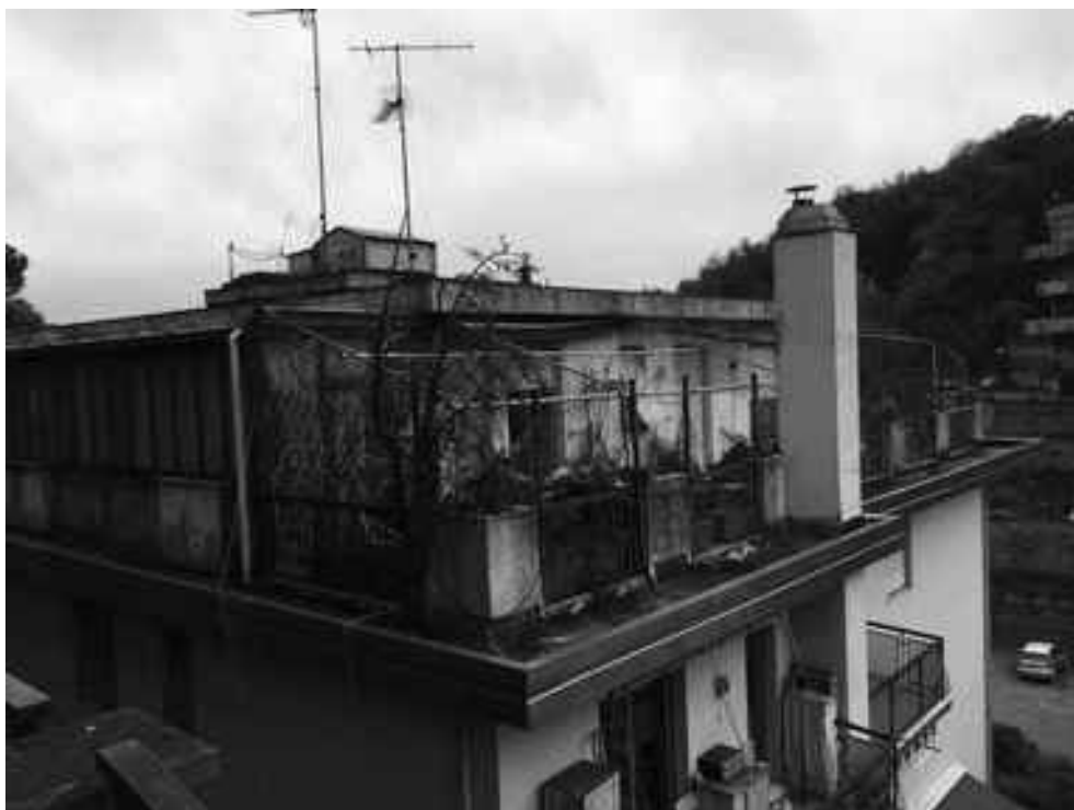
Foto n°15 – Vista esterna porz. attico civ. 90\20 di Via Laggiaro, in Rapallo (GE)
