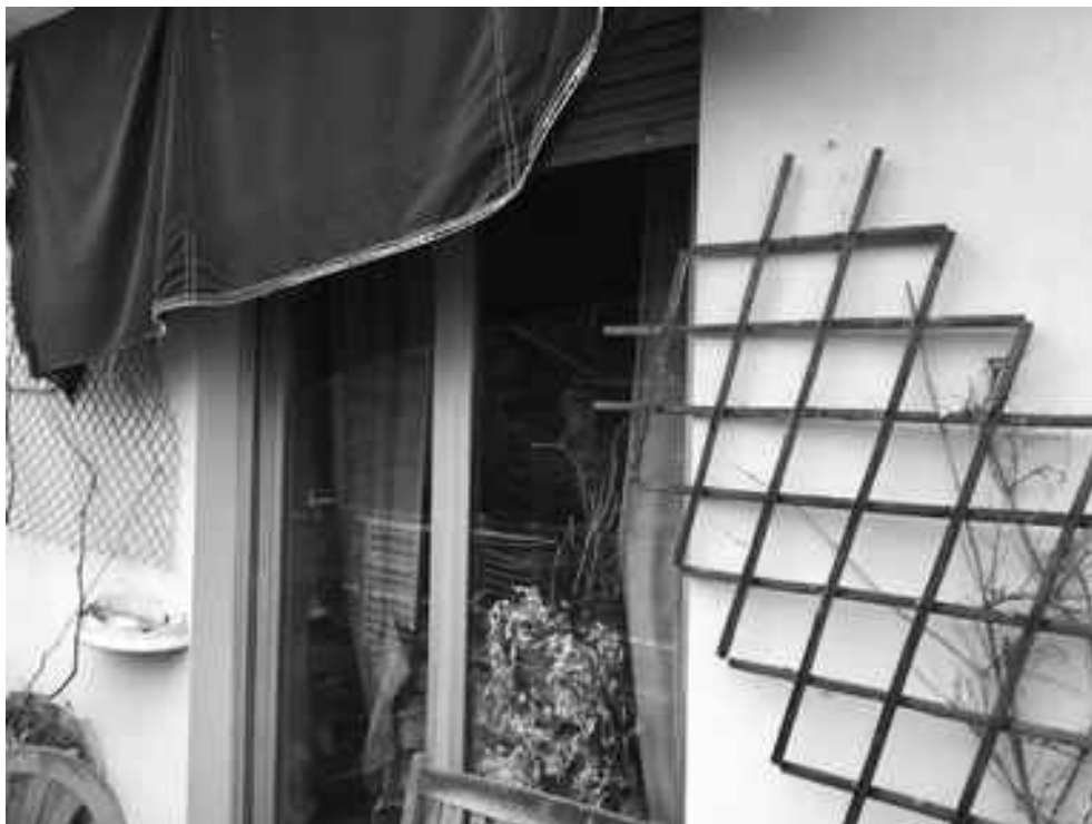
Foto n° 27 – dettagli serramenti– infissi in alluminio appartamenti
