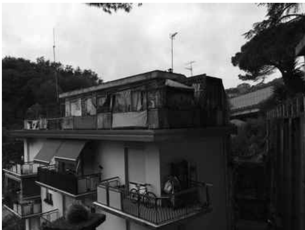
Foto n°5 – Vista esterna porz. attico civ. 90\19 di Via Laggiaro, in Rapallo (GE)
