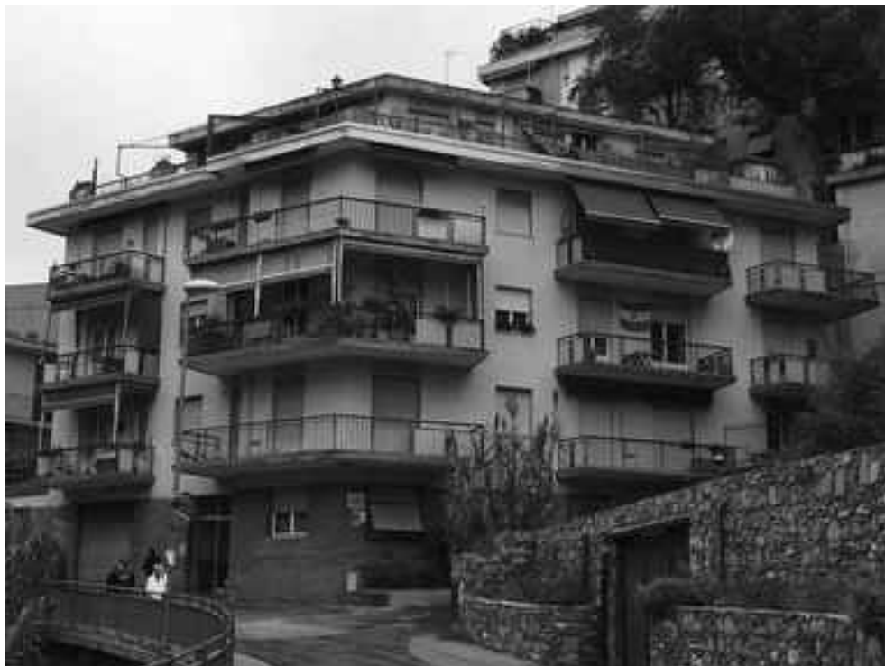
Foto n°2 – Vista esterna immobile civ. 90 di Via Laggiaro, in Rapallo (GE)
