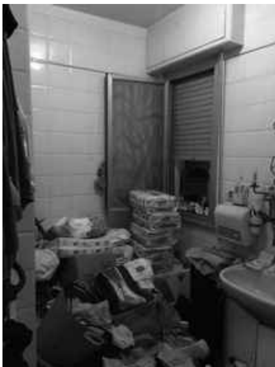
Foto n° 11 – Vista interna appartamento Int. 19 – Piano quarto – bagno
