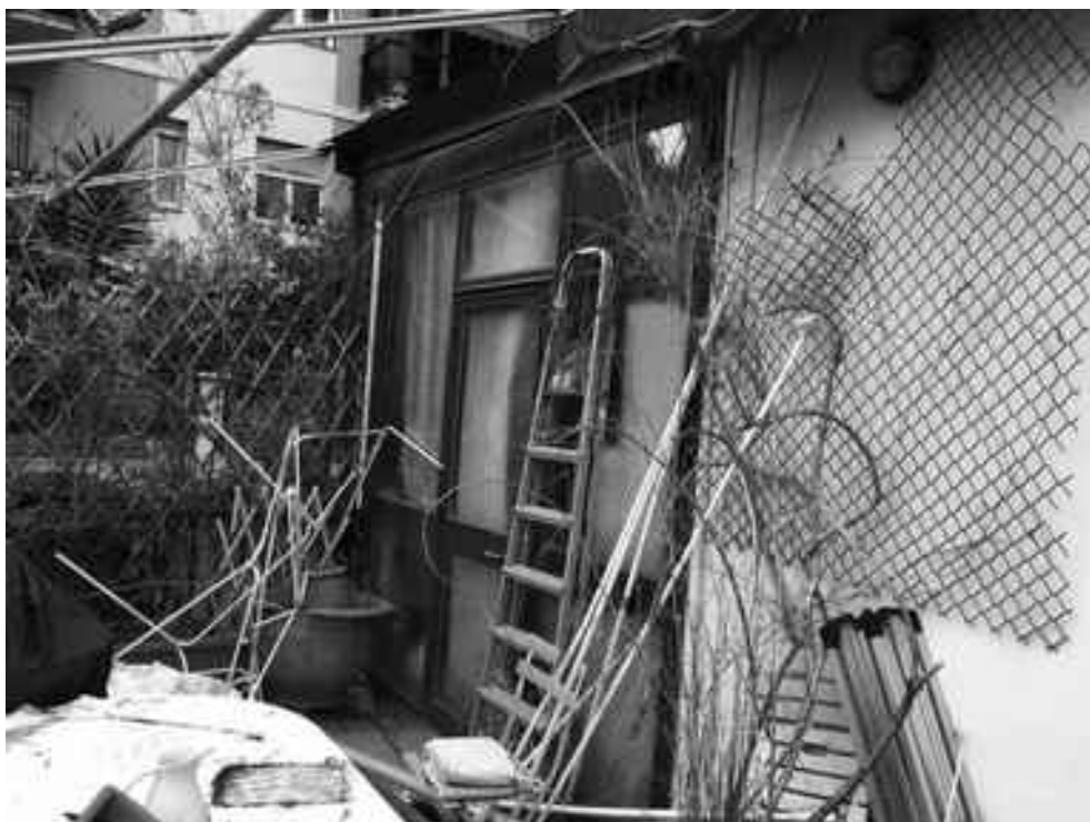
Foto n° 28 – dettaglio serramenti– infissi in alluminio strutture a veranda
