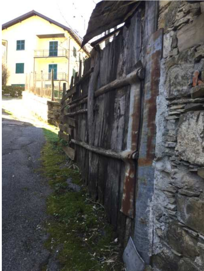
Foto n. 12- Facciata lato Est verso la legnaia
