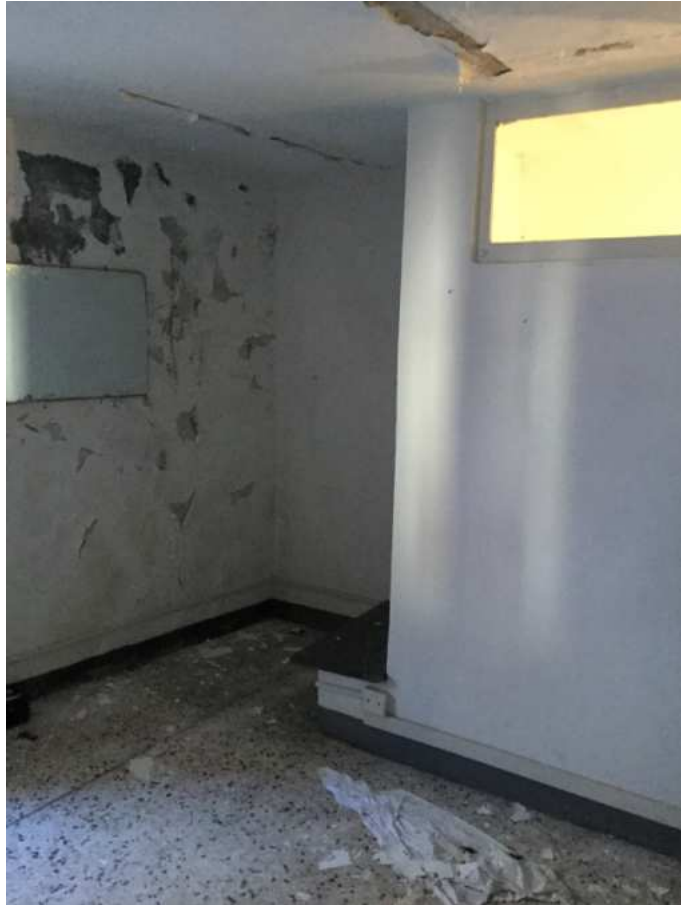
Foto n. 39- Camera primo piano
