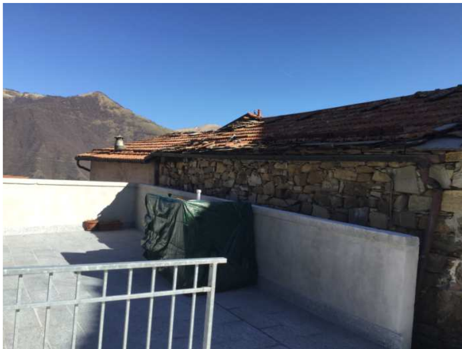
Foto n. 18- Facciata legnaia lato Est . Parapetto di altra proprietà in primo piano.
