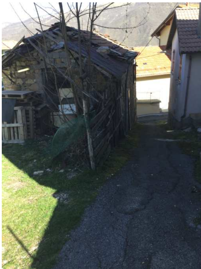
Foto n. 13- Legnaia e corte ripresa da Sud
