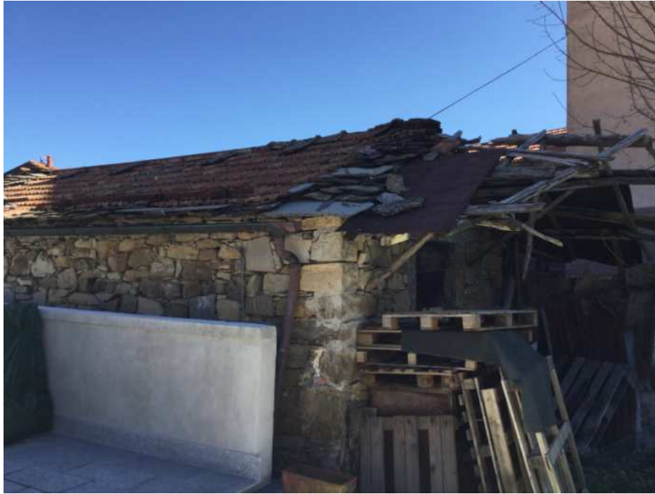
Foto n. 17- Facciata legnaia lato Est . Parapetto di altra proprietà in primo piano.
