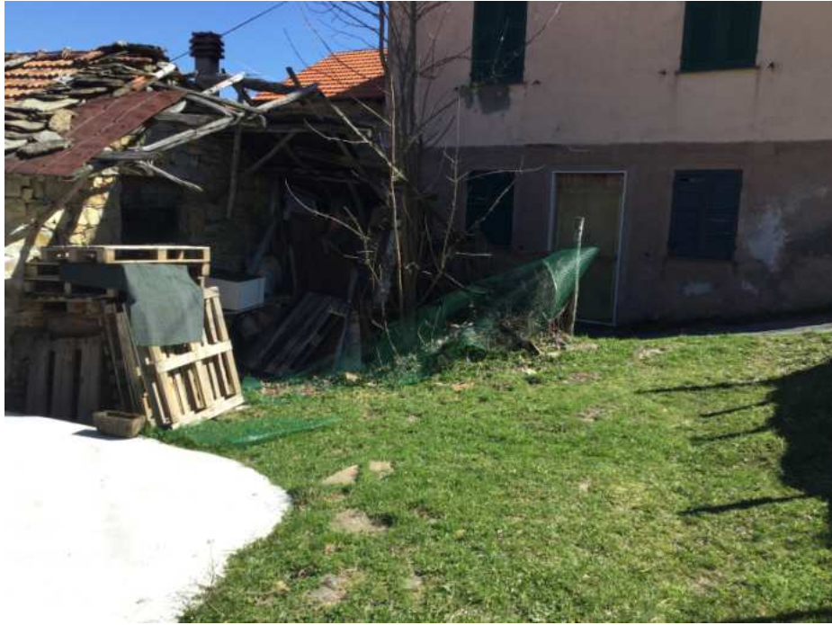
Foto n. 19- Corte e legnaia ripresa verso la stradina
