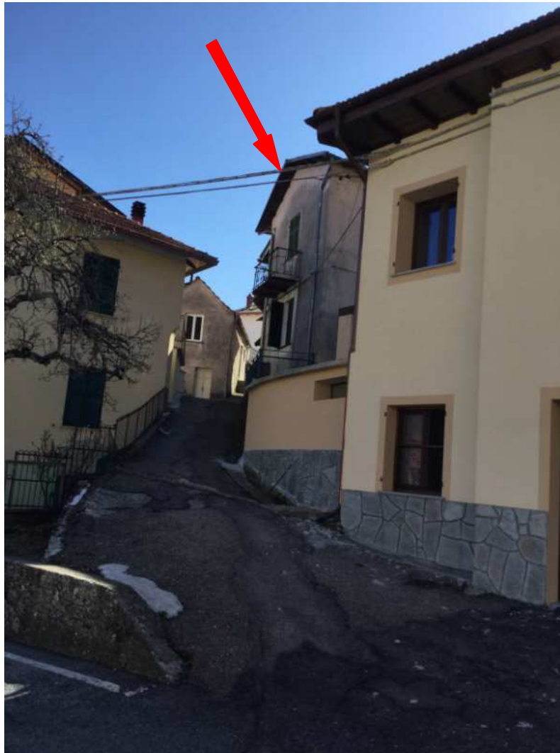
Foto n. 1- Immobile da terra a tetto – Frazione Fontanarossa n.82 Comune di Gorreto ( Ge). Immagine ripresa dalla strada comunale di accesso.
