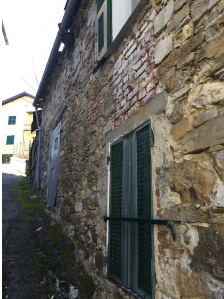
Foto n. 9- Particolare facciata lato Est
