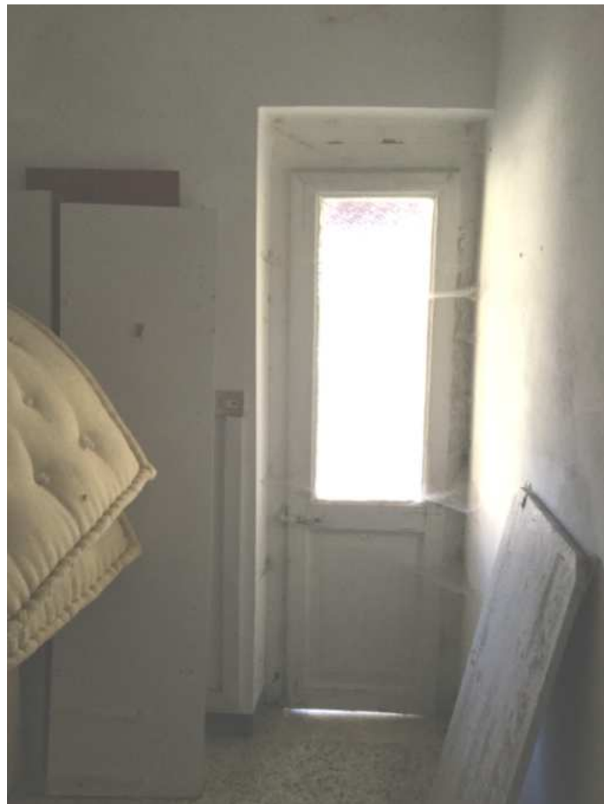
Foto n. 45- Camera con esposizione Nord Est. Piccola porta finestra di accesso al poggiolo ad Est
